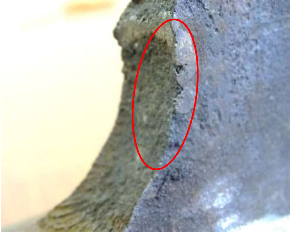
照片十二：斷裂鋼軌之斷裂起始位置位於軌腹表面訊號線接點處（圓圈處）
