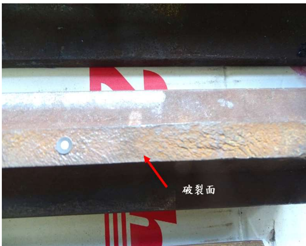
照片十五：斷裂鋼軌之破裂面呈現快速破壞型態
