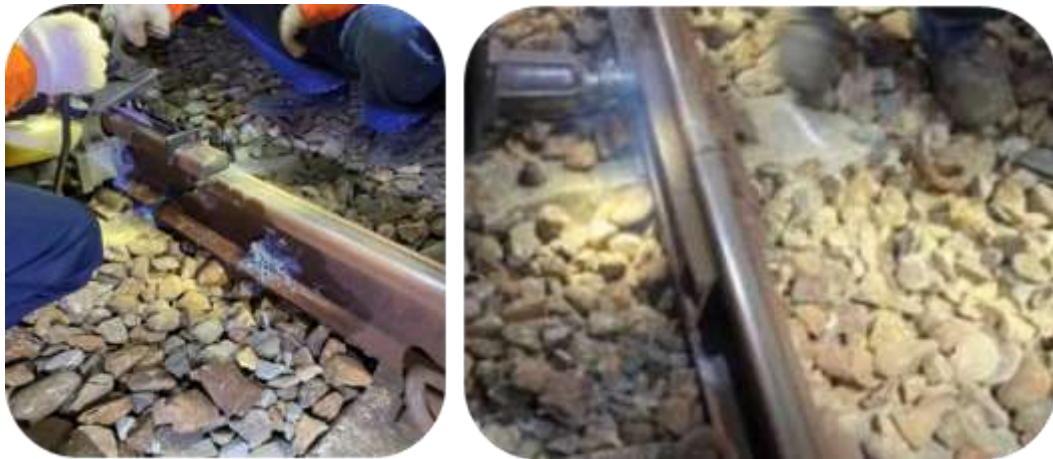
圖 1.5-4 鋼軌裂痕緊急搶修及魚尾板加固
