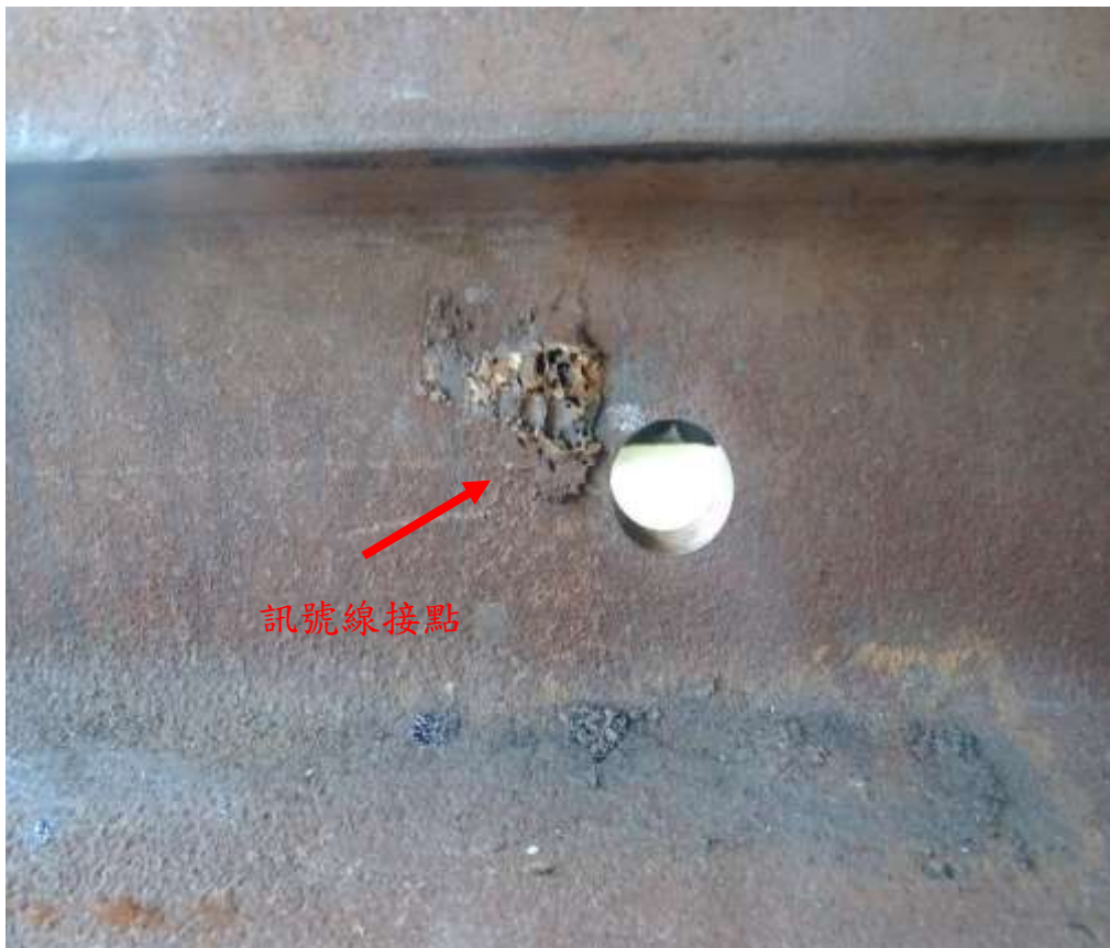
照片七：鋼軌另一訊號線接點
