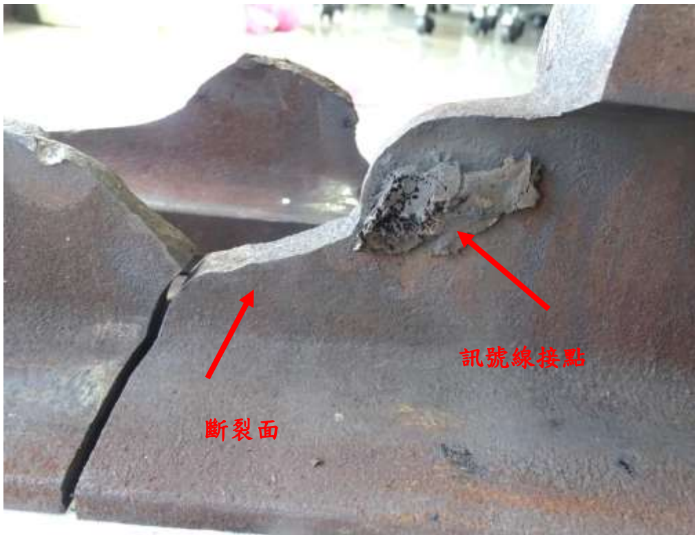
照片五：鋼軌斷裂起始位置位於訊號線接點處
