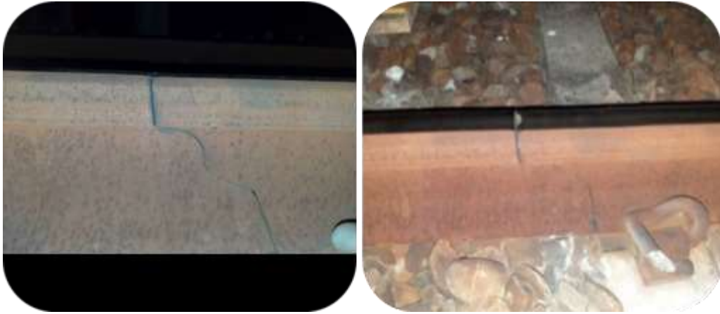
圖 1.5-3 109 年 3 月 3 日之鋼軌裂痕
