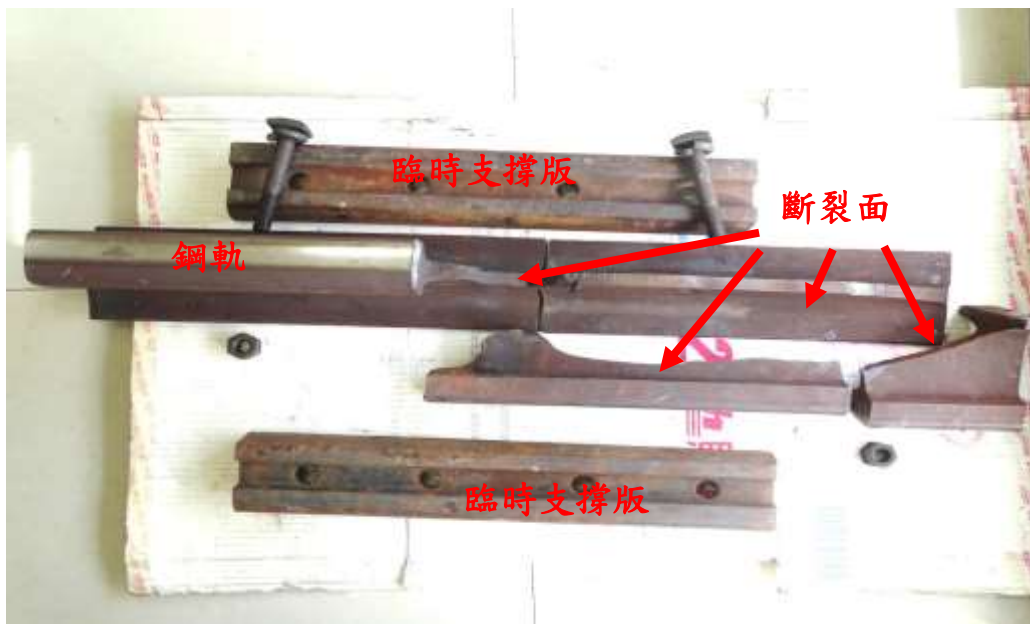
照片三：斷裂鋼軌整體外貌
