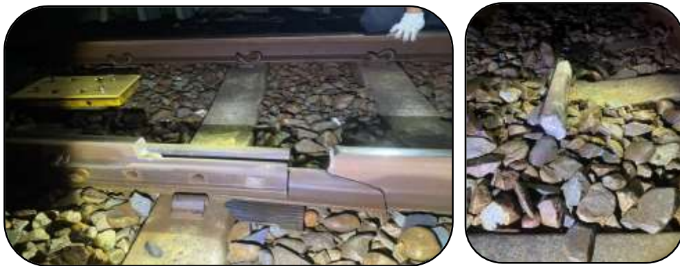
圖 1.1-3 鋼軌斷裂
