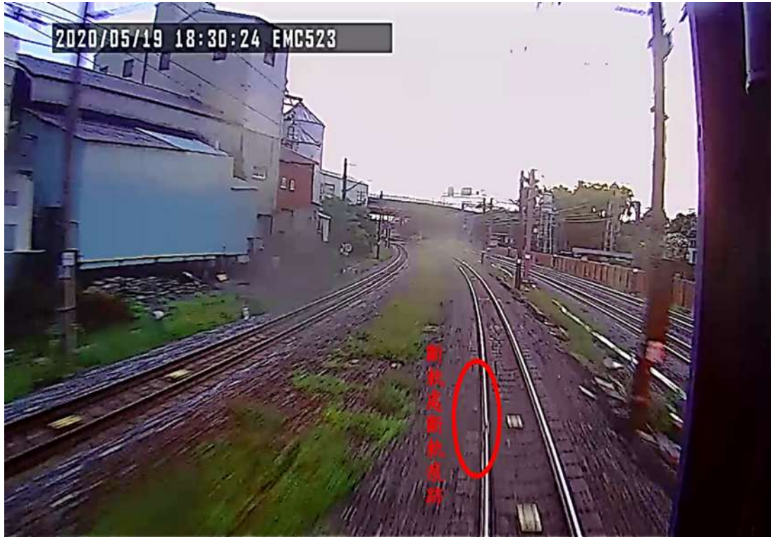
圖 1.9-2 第 2246 次車車後影像顯示鋼軌踏面脫離
