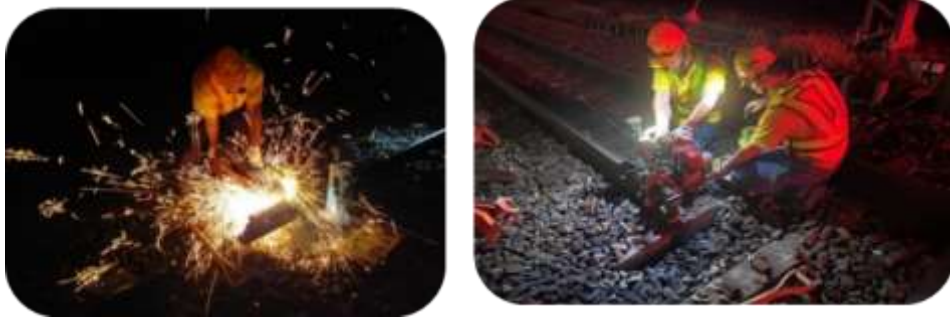
圖 1.1-4 本事故第一階段鋼軌斷裂搶修過程
