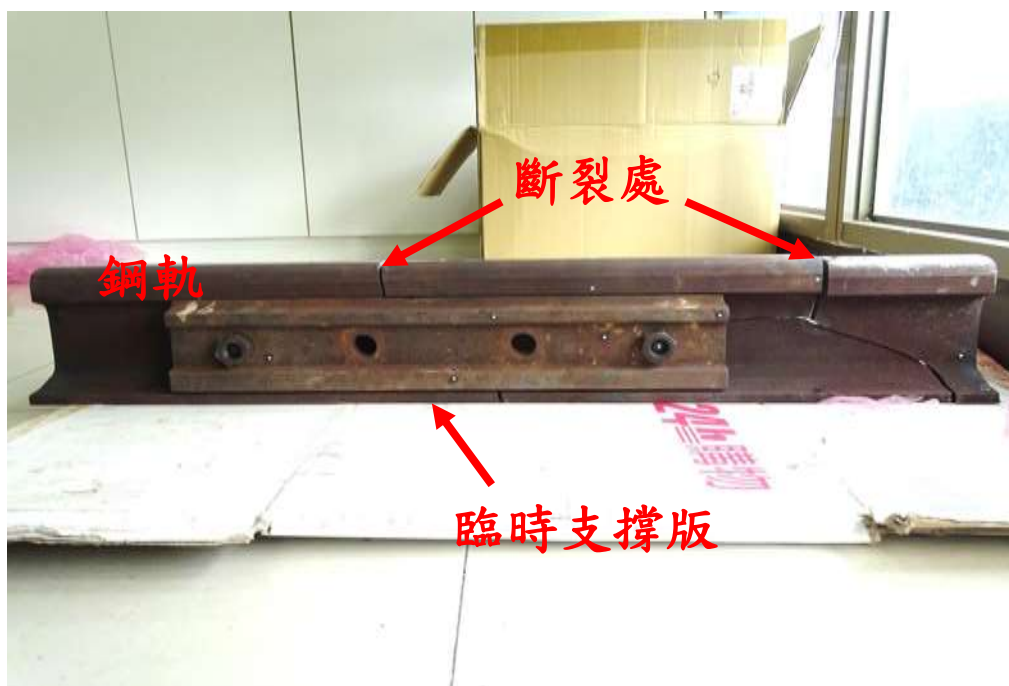
照片一：斷裂鋼軌組合後外觀
