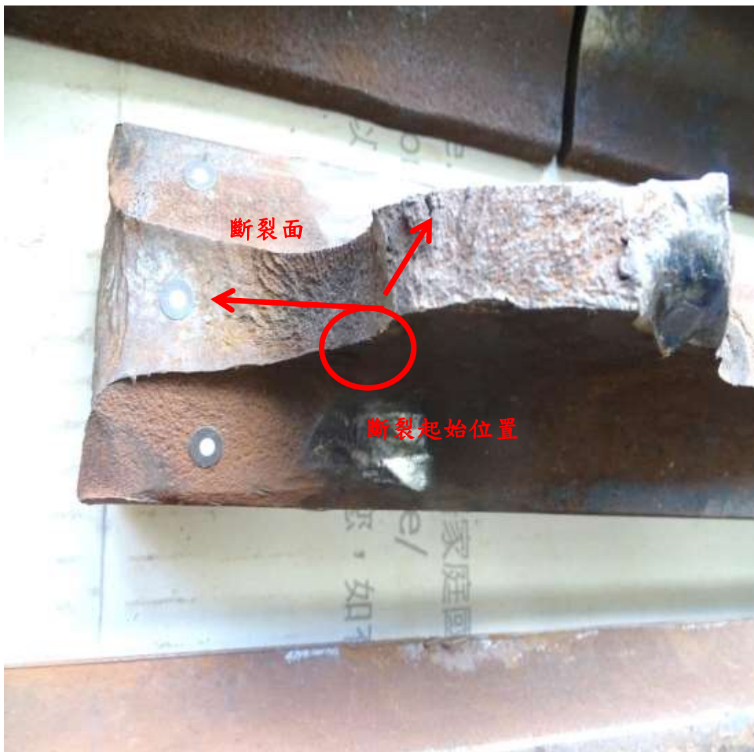
照片十一：斷裂鋼軌之斷裂起始位置位於軌腹表面訊號線接點處（圓圈處），破裂成長由訊號線接點往鋼軌內部成長延伸
