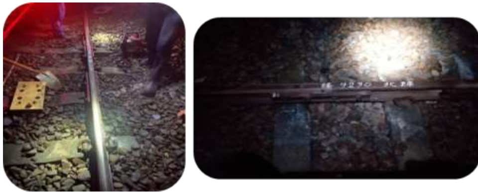
圖 1.1-5 第一階段鋼軌斷裂搶修完工
