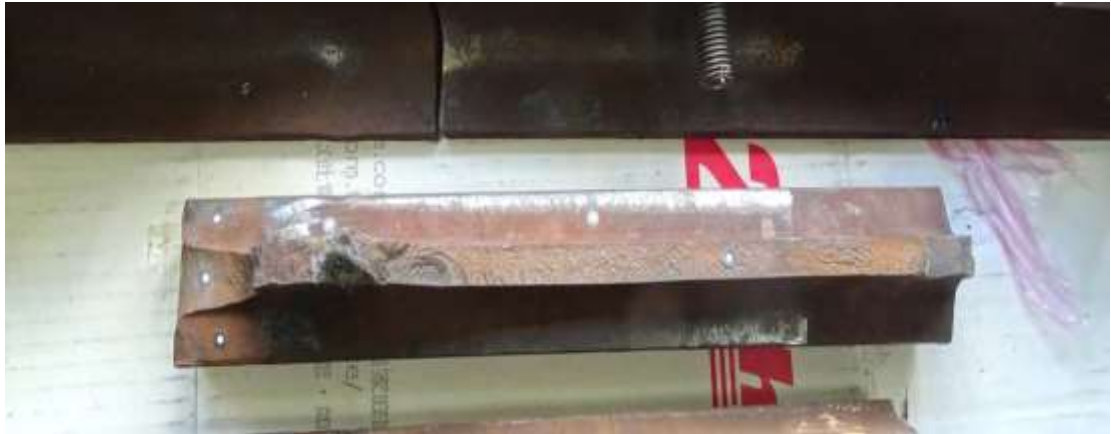
照片十：斷裂鋼軌之破裂面呈現快速破壞形貌
