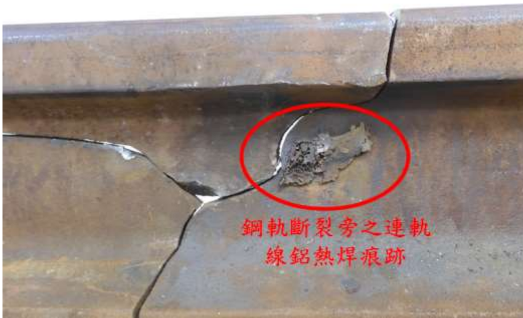
圖 1.5.2 鋼軌斷裂旁之連軌線鋁熱焊痕跡
