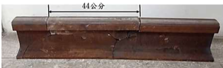
圖 1.1-1 鋼軌斷裂（組合）
