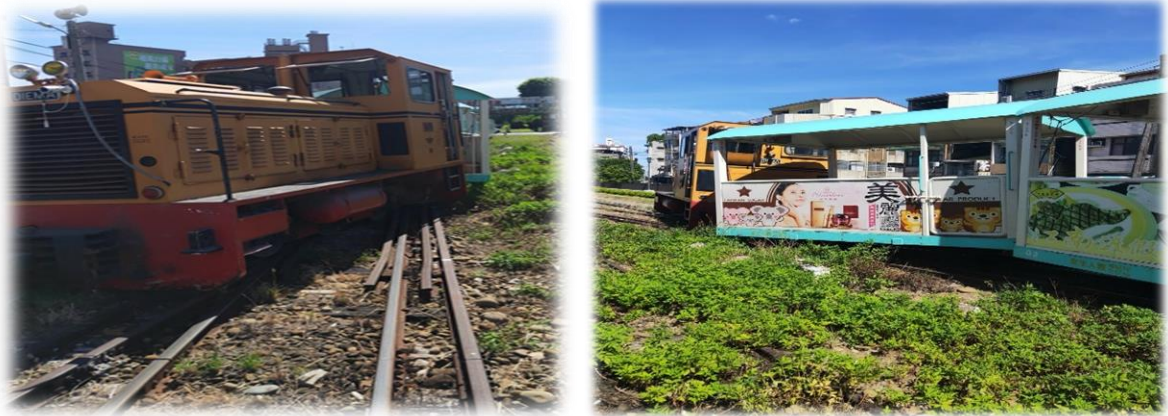
圖 2.1.3-10 0628 台糖第 101 次車新營糖廠重大鐵道事故照片
