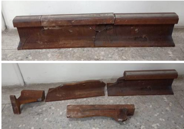
圖 2.1.3-5 內軌斷裂照片
