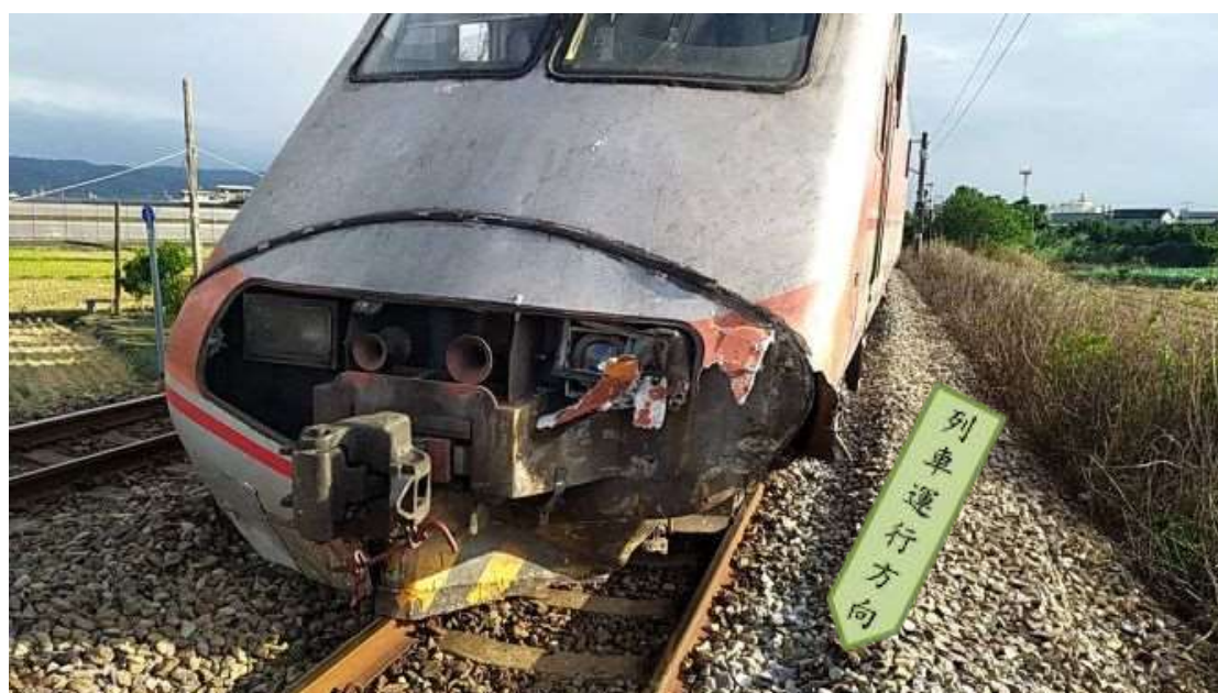
圖 1.1-5 E1020 機車損毀狀況
