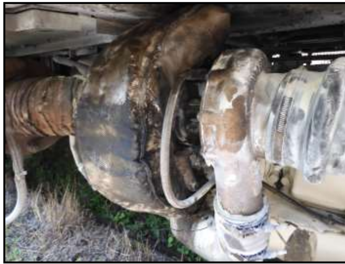
圖 1.1-1 車底左（山）側渦輪增壓機與護罩損毀
