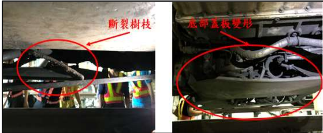
圖 1.7-9 列車底部之斷裂樹枝及蓋板變形情況
