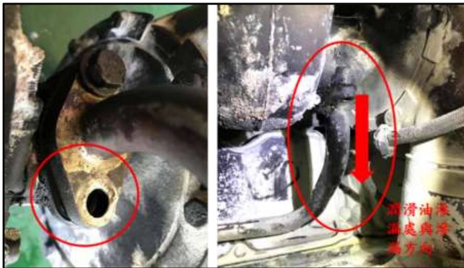
圖 1.7-10 回油管與渦輪增壓機接合處螺絲缺少與漏油位置
