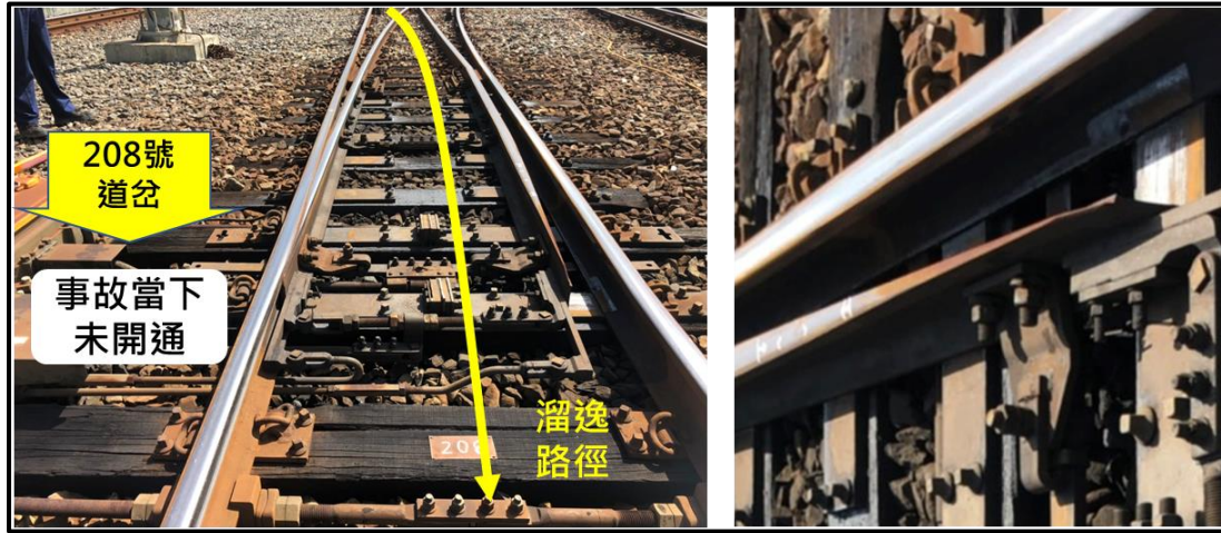
圖 1.10-2 第 208 號道岔檢查（事故當日）
