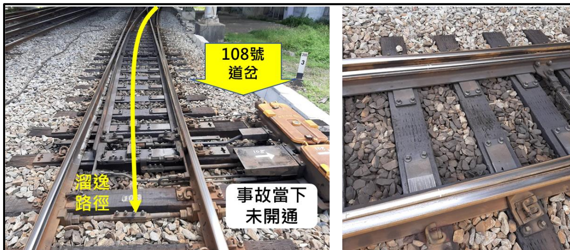
圖 1.10-4 第 108 號道岔檢查（事故當日）
