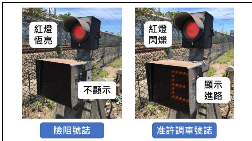
圖 1.7-10 本次事故列車通過 82R 調車號誌機顯示（非事故當日）
