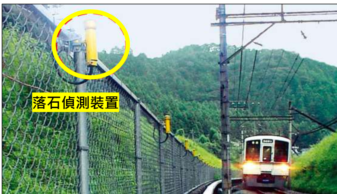
圖 1.7-11 西武鐵道落石偵測告警裝置 17
