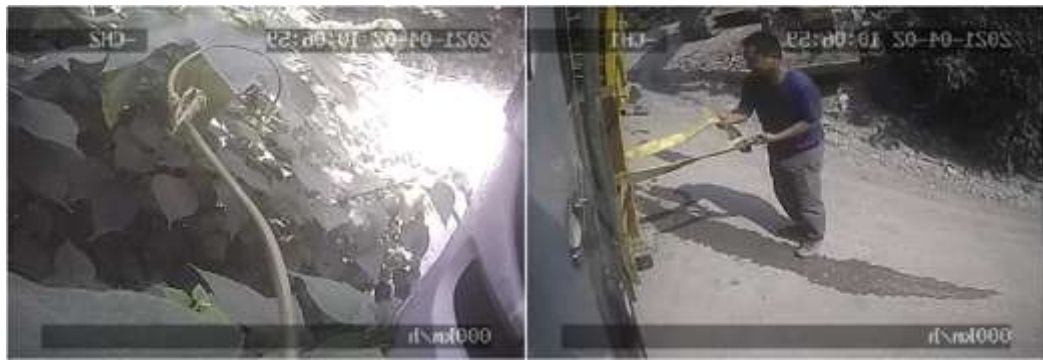
圖 1.10-29 工地主任將吊帶綁上大貨車立柱
