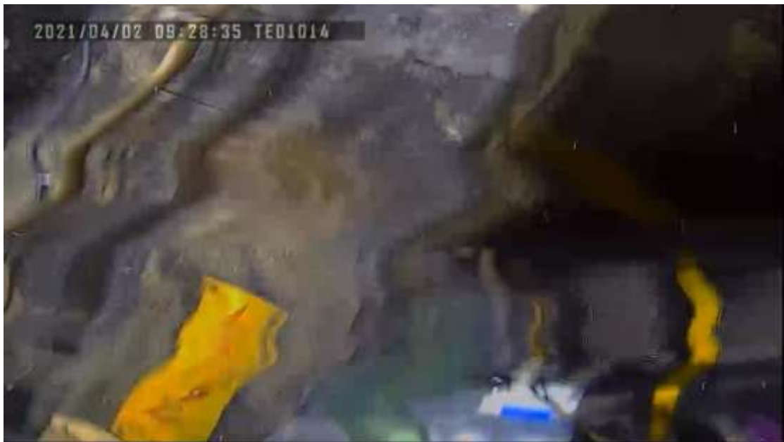
圖 1.10-39 列車撞及清水隧道北口東側
