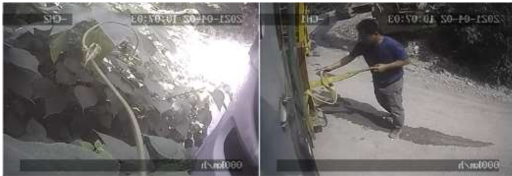
圖 1.10-30 工地主任將吊帶綁上大貨車立柱
