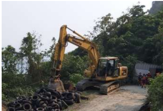
圖 1.8-3 事故挖掘機外觀照片
