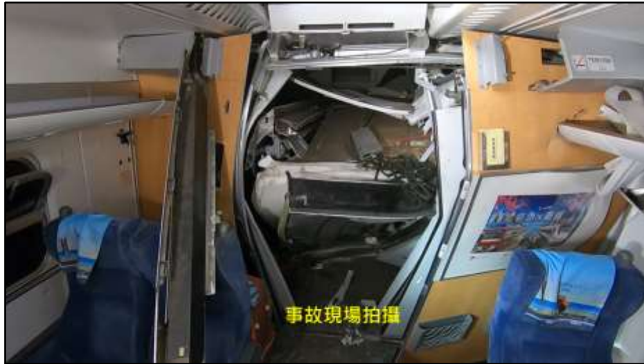
圖 1.13-8 第 5 車後端受損情形
