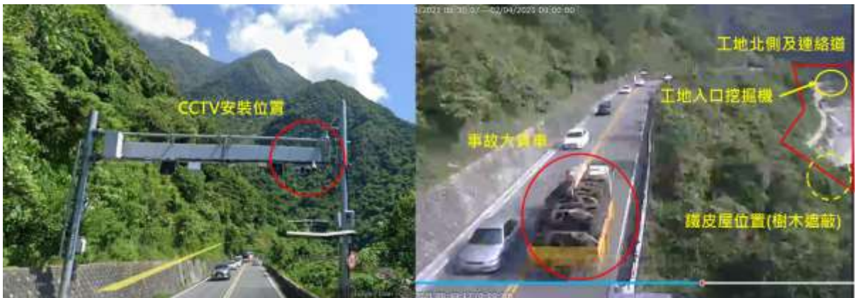
圖 1.10-22 台 9 線 CCTV R-158.520 安裝位置及畫面相關資訊
