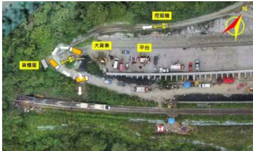
圖 1.1-3 大貨車移動及挖掘機停放位置說明
