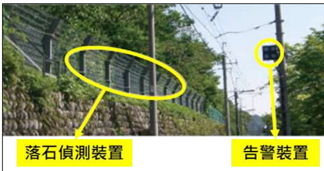
圖 1.7-10 東武鐵道落石偵測告警裝置 16
