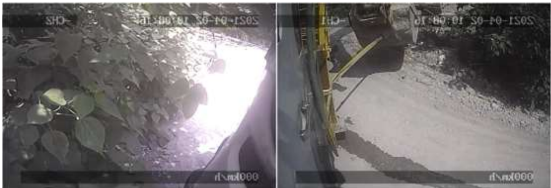
圖 1.10-33 挖掘機第二次拖動大貨車
