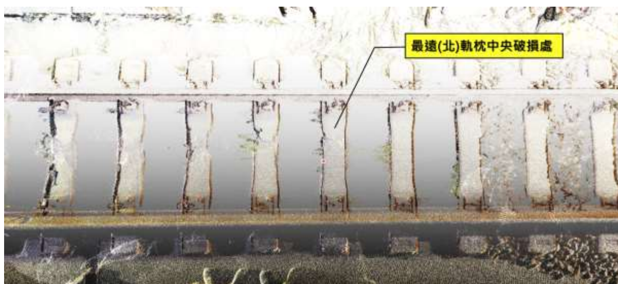
圖 1.11-13 受破壞最遠處軌枕狀況
