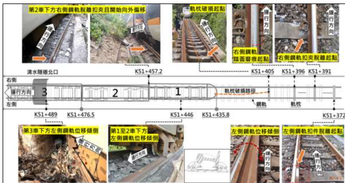
圖 1.3-9 清水隧道外軌道損害情形
