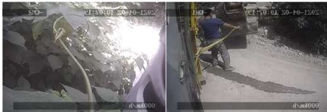
圖 1.10-31 工地主任將吊帶另一端扣於挖掘機挖斗
