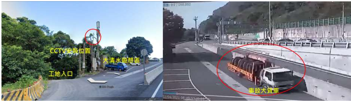
圖 1.10-24 台 9 丁線 CCTV 068.960 安裝位置及畫面相關資訊
