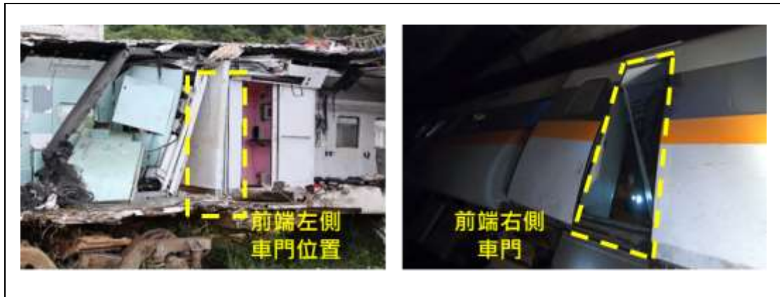
圖 1.13-23 第 8 車前端左、右側車門及玄關通道
