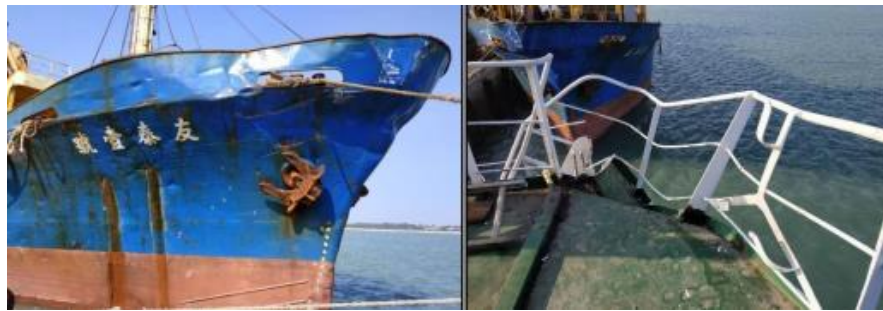
圖 2.2.2-23 友泰 1 號與浯洲寶瓶號受損情形
