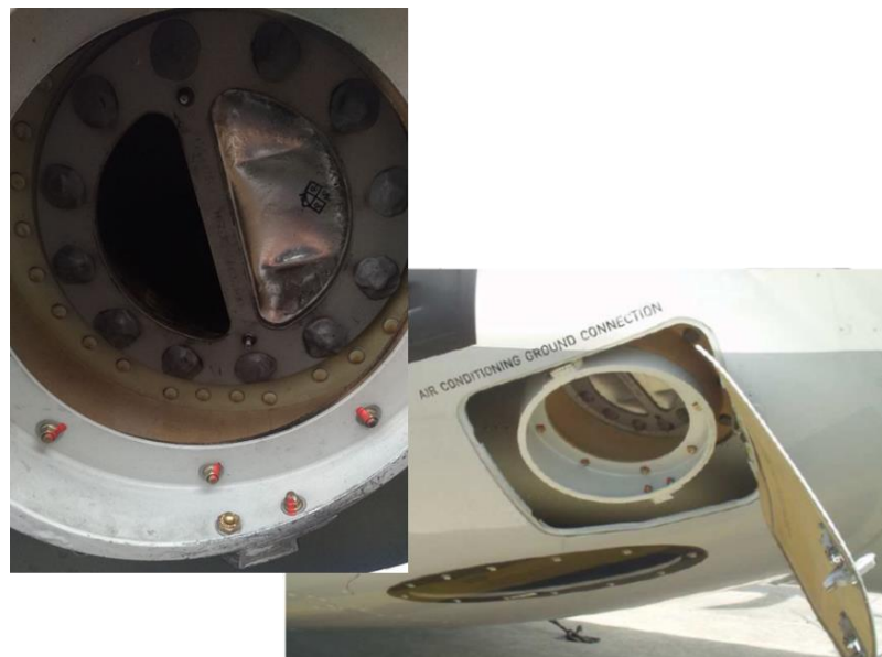
圖 2.2.1-8 ATR-72 型機空調地面連接單向閥外觀及失效位置
