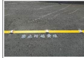
不影響船舶離靠安全下增設反光警示標線(記)
