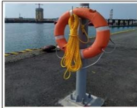
碼頭岸肩後方適當地點設置救生器材(如救生圈、立桿及拋繩)
