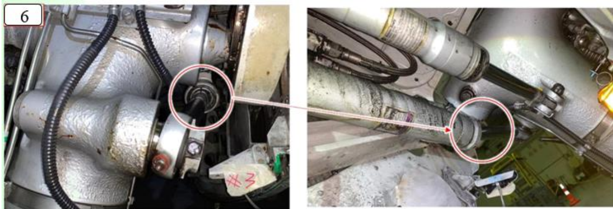
圖 1.12-4 右起落架受損照片
