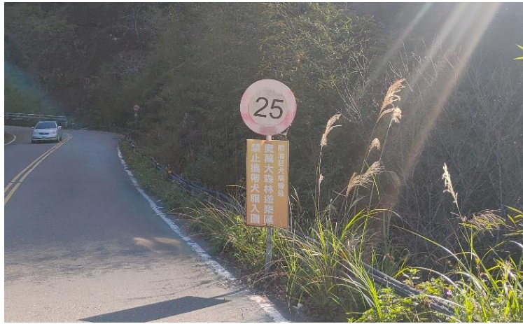
圖 1.8-4 速限標誌有明顯退色情形
