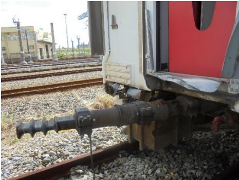
連結器受損情形
