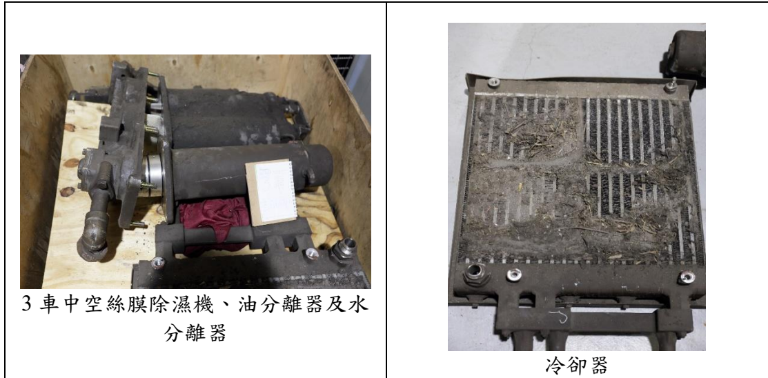
圖 1.3-14 第 3 車損傷概況圖
