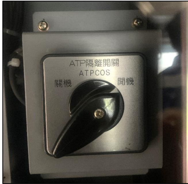
圖 1.8-5 駕駛室背向面板的 ATP 隔離開關
