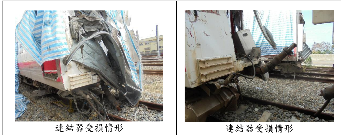
圖 1.3-6 第 7 車連結器損傷概況
