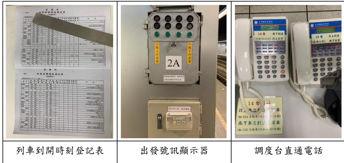
圖 1.11-5 高雄站行車室部分設備圖
