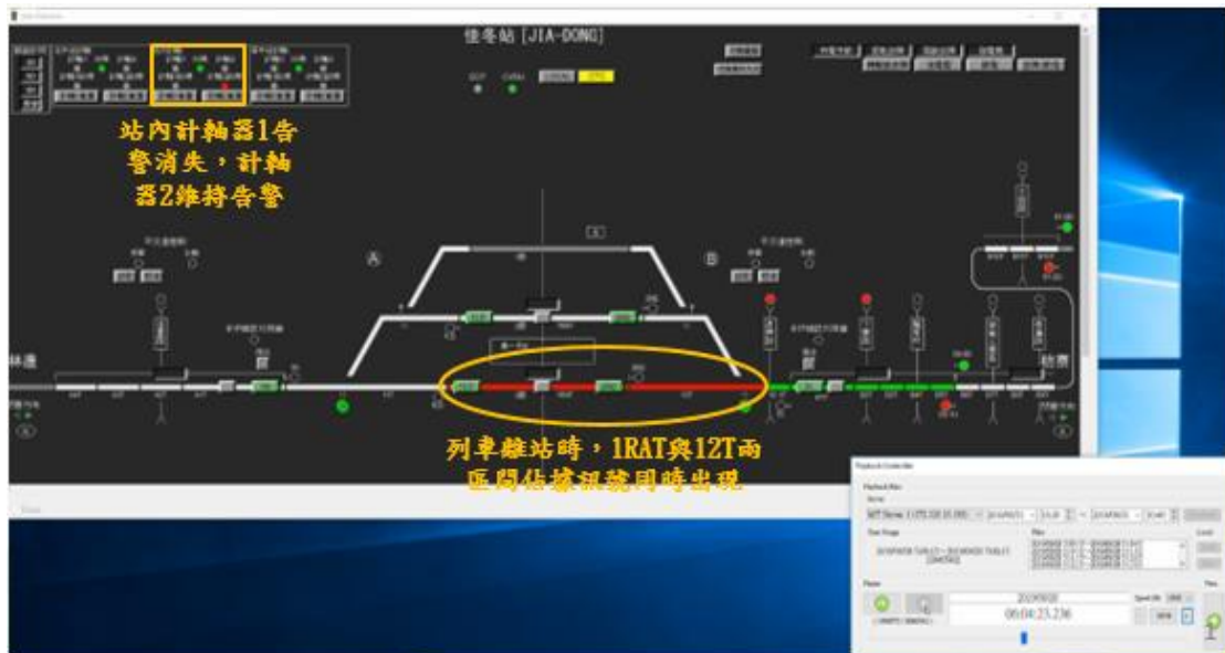
圖 1.9-27 第 3501 次車佳冬站離站期間產生之異常 (1)
