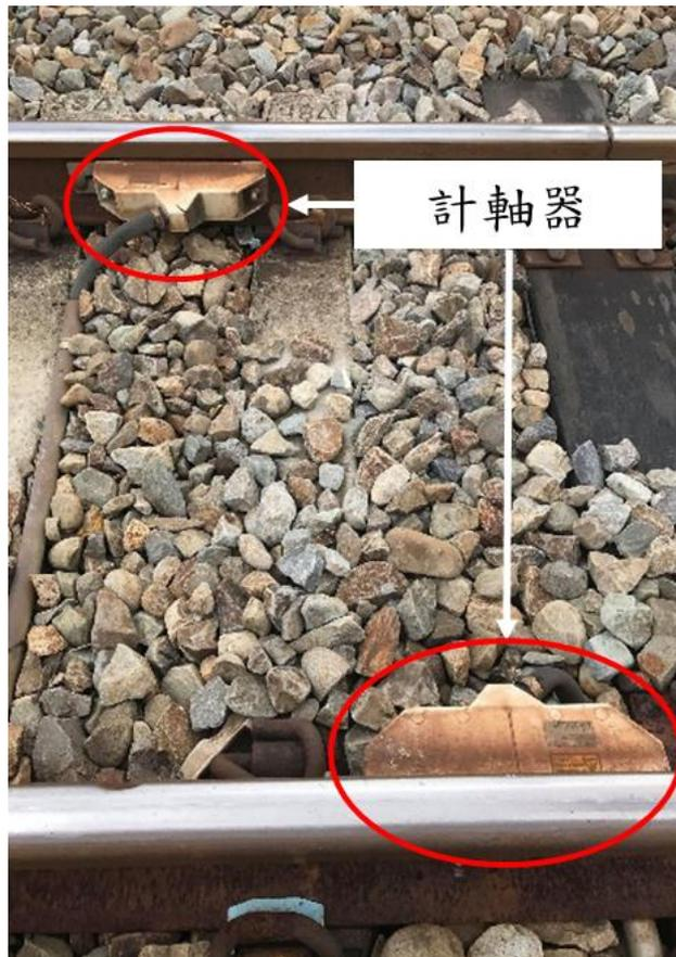
圖 1.5-2 雙計軸器系統
