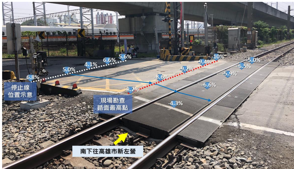
圖 1.5-10 平交道東側坡度示意圖
