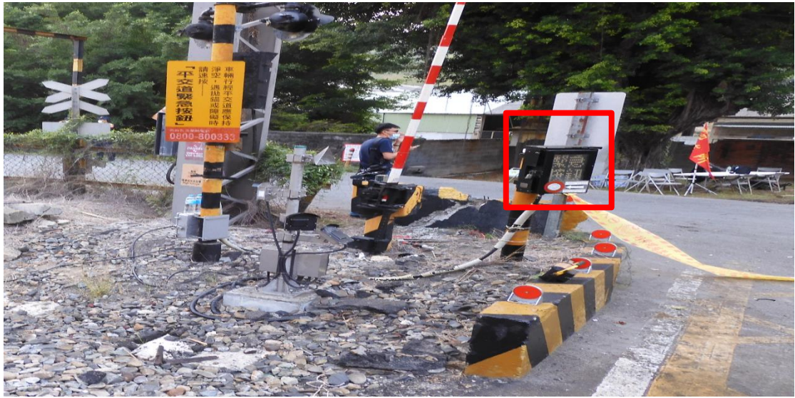
圖 1.5-14 手動緊急告警設備圖示
