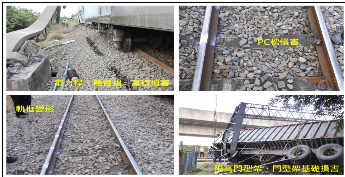
圖 1.3-2 軌道受損情形說明-2
