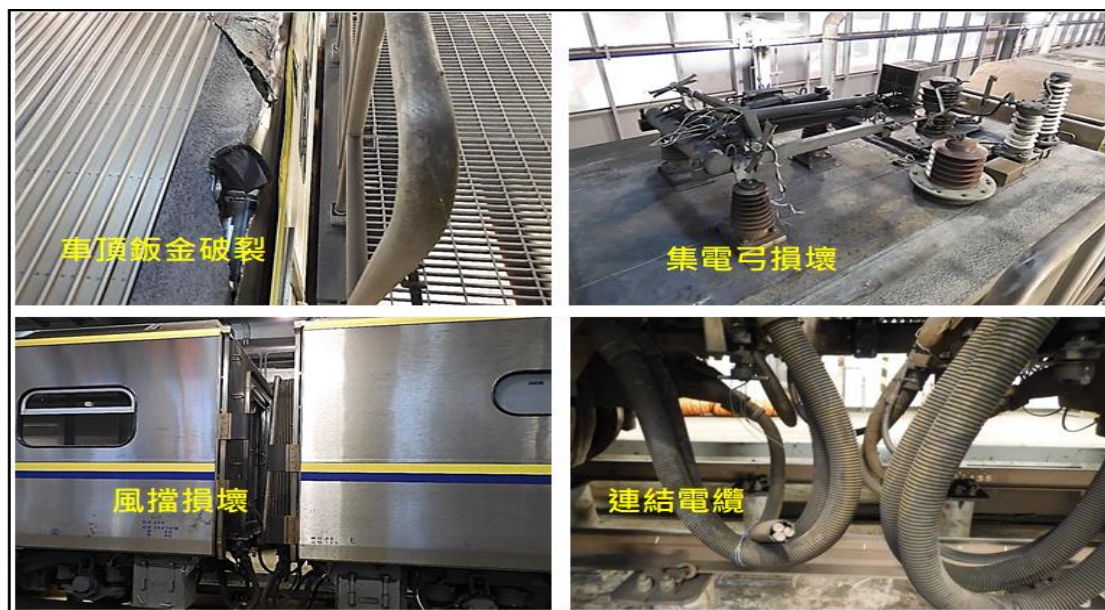
圖 1.2-7 編號6車損害情形-2
