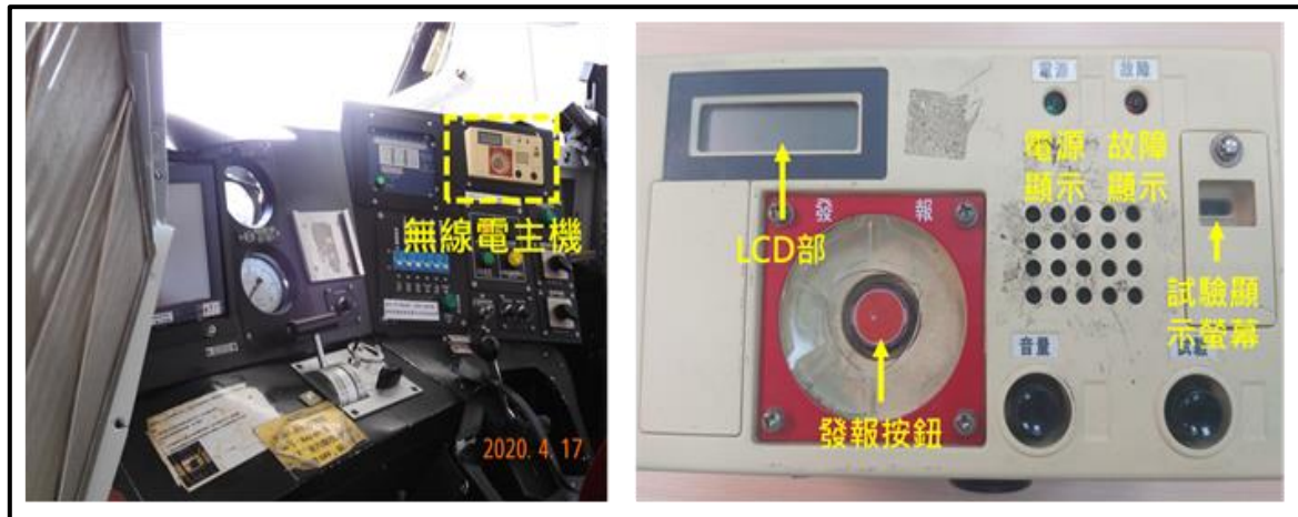
圖 1.14-1 編號 8 車無線電主機
