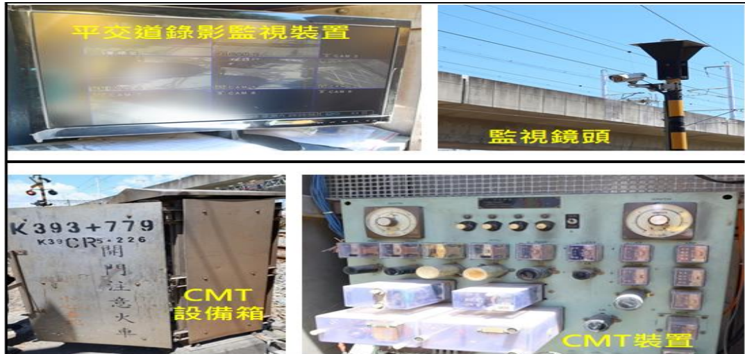
圖 1.5-17 屏山巷平交道錄影監視裝置與集中監視裝置
