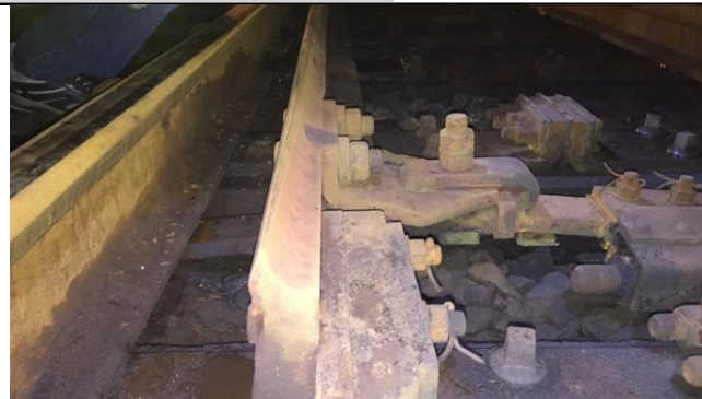
七堵 514 轉轍器故障排除前左側(反位側)桿件彎曲
