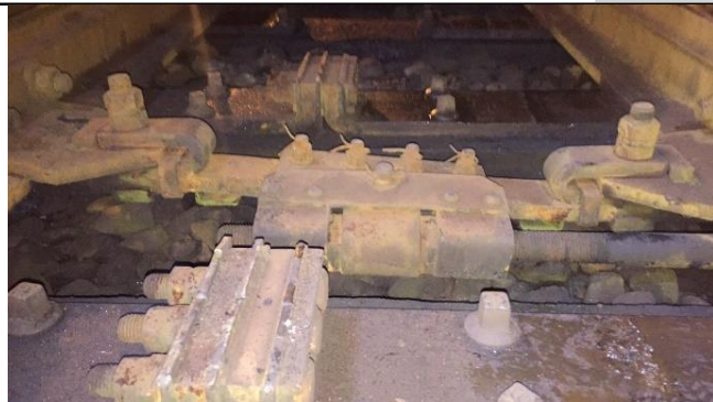
七堵 514 轉轍器故障排除前左側(反位側)桿件彎曲
