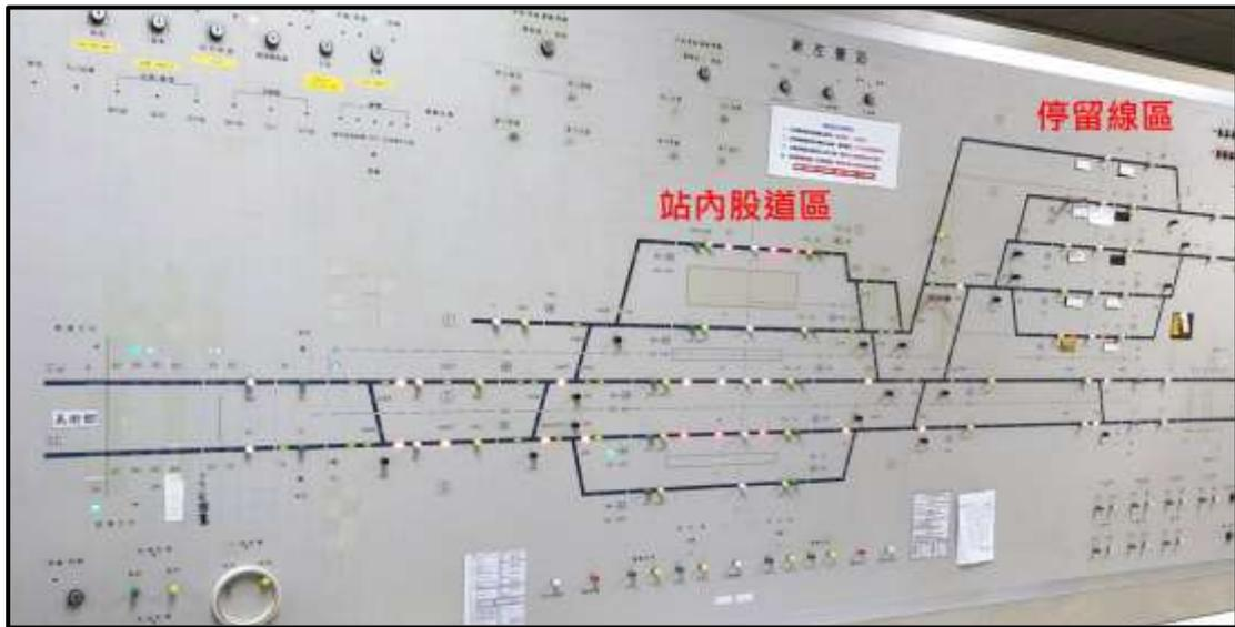
圖 1.7-2 新左營站行車室就地控制設備（新左營站部分）
