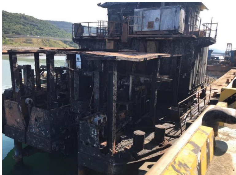
圖 2.2.2-64 昭伸二號挖泥船
