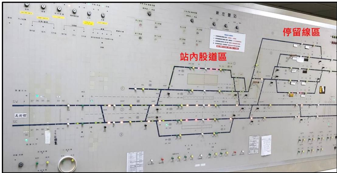
圖 1.7-2 新左營站行車室就地控制設備（新左營站部分）
