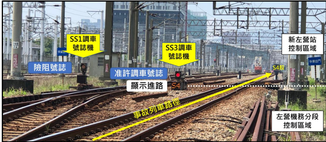
圖 1.7-12 SS3 調車號誌機顯示（非事故當日）
