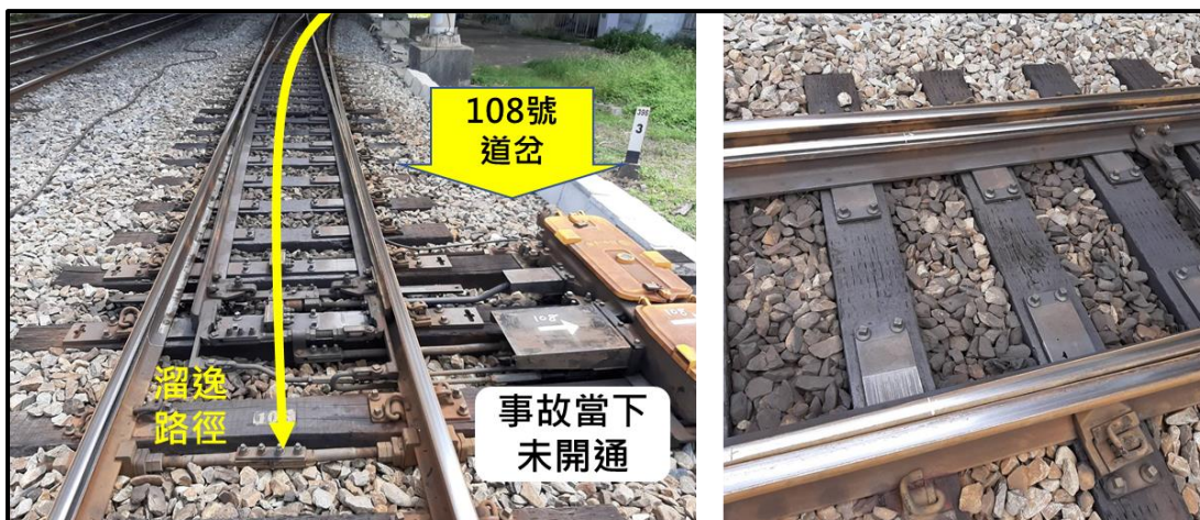
圖 1.10-4 第 108 號道岔檢查 (事故當日)
