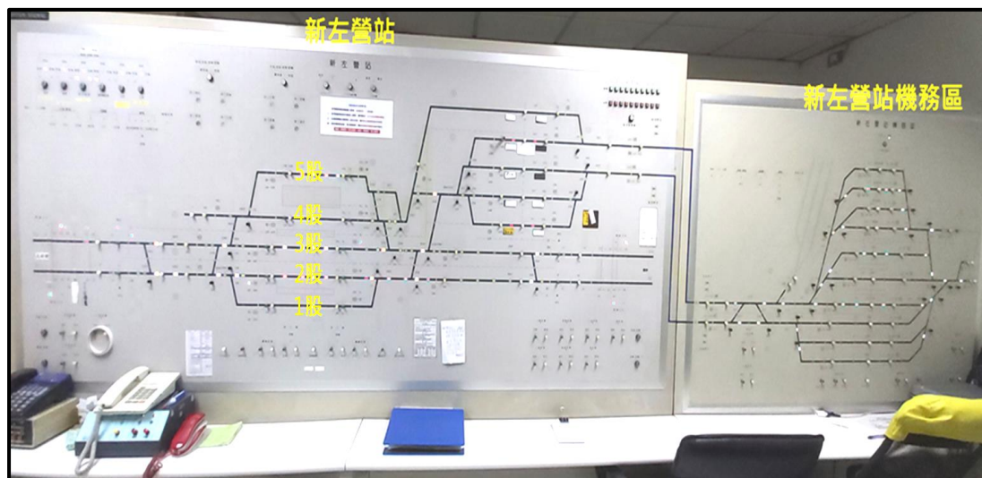
圖 1.7-1 新左營站行車室就地控制設備
