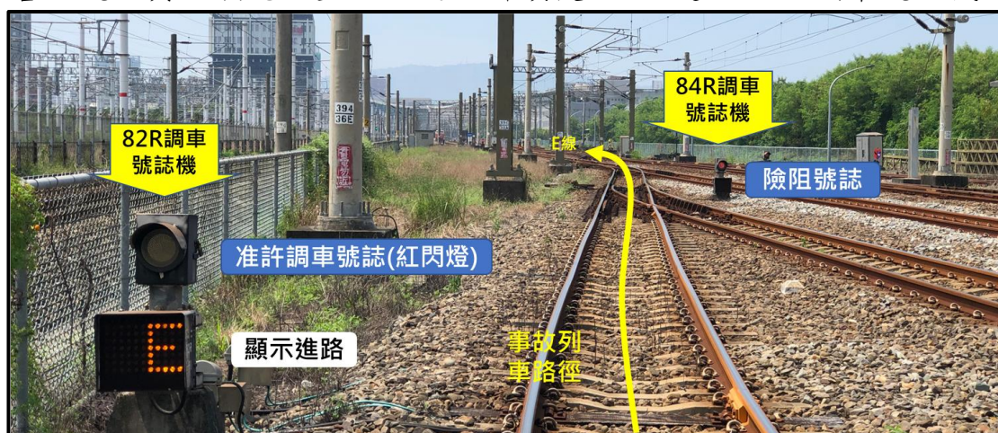
圖 1.7-9 82R 調車號誌機顯示（非事故當日）
