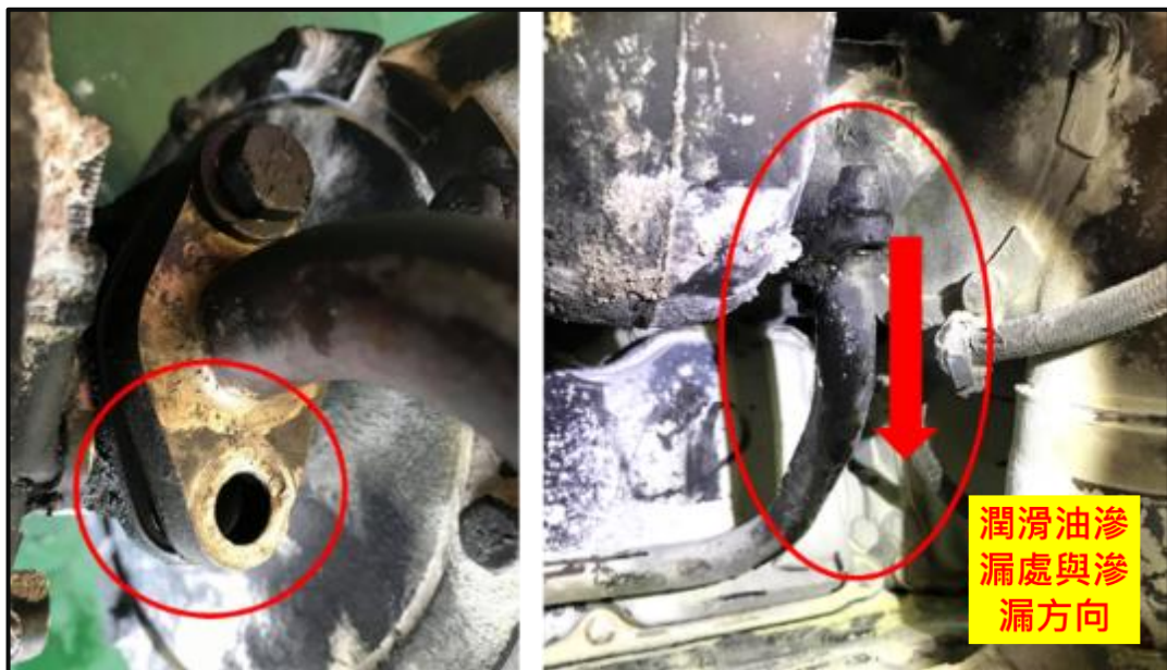
圖 1.8-12 回油管與渦輪增壓機接合處螺栓缺少與漏油位置
