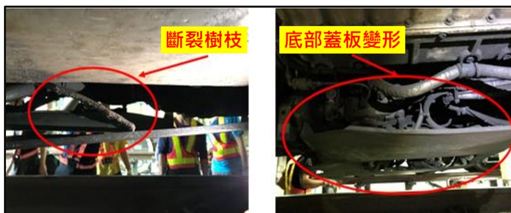
圖 1.8-10 列車底部之斷裂樹枝及蓋板變形情況
