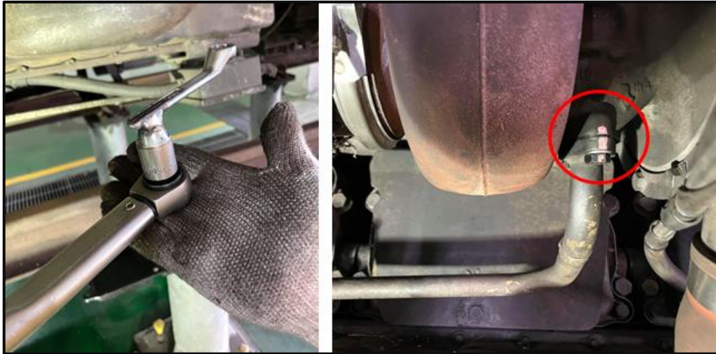
圖 2.3-2 改造後扭力扳手與螺栓接合處畫線標記
