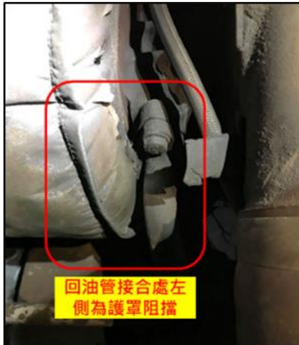
圖 2-2-1 回油管彎曲處與接合處及左側渦輪增壓機護罩
