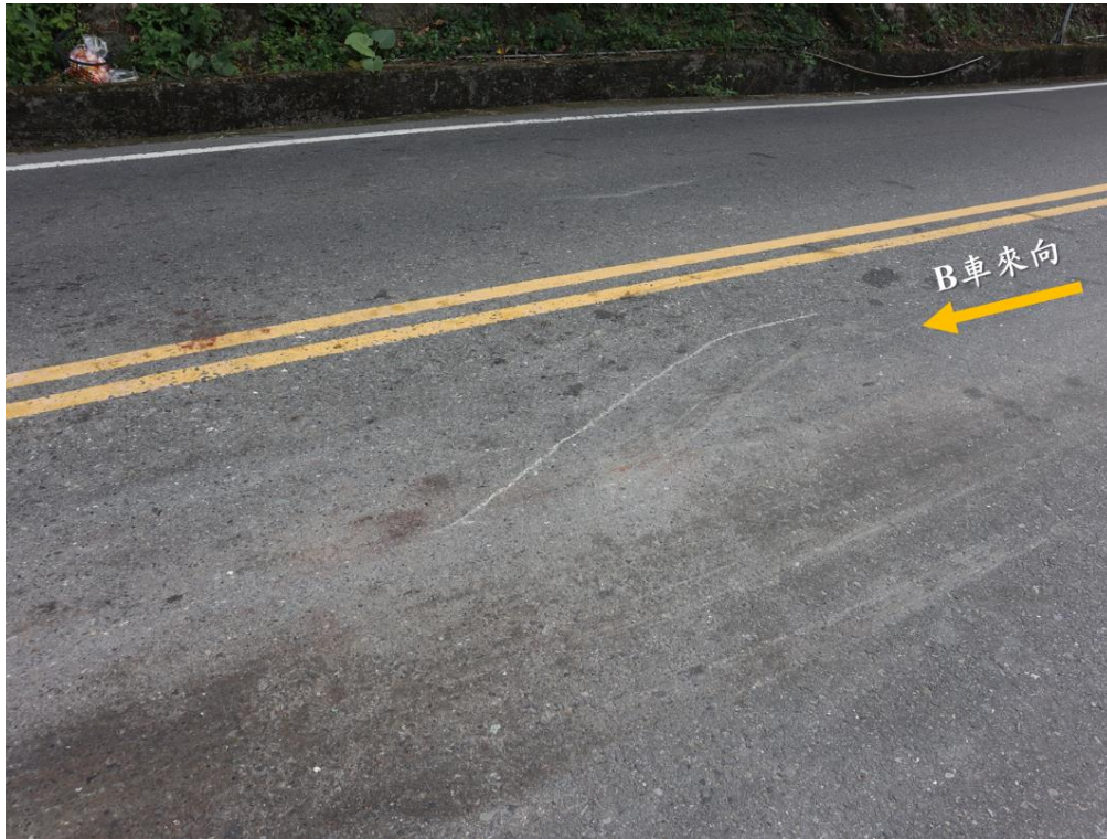
圖 1.10-3 路面刮地痕跡
