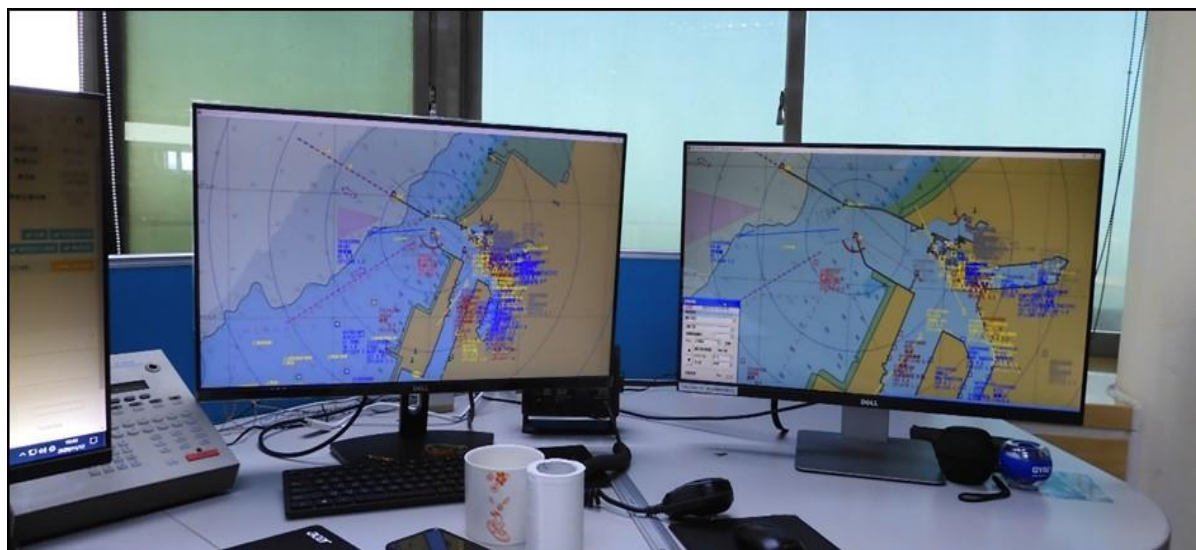
圖 1.9.5.2-1 臺中港 VTS 監控系統畫面照片
