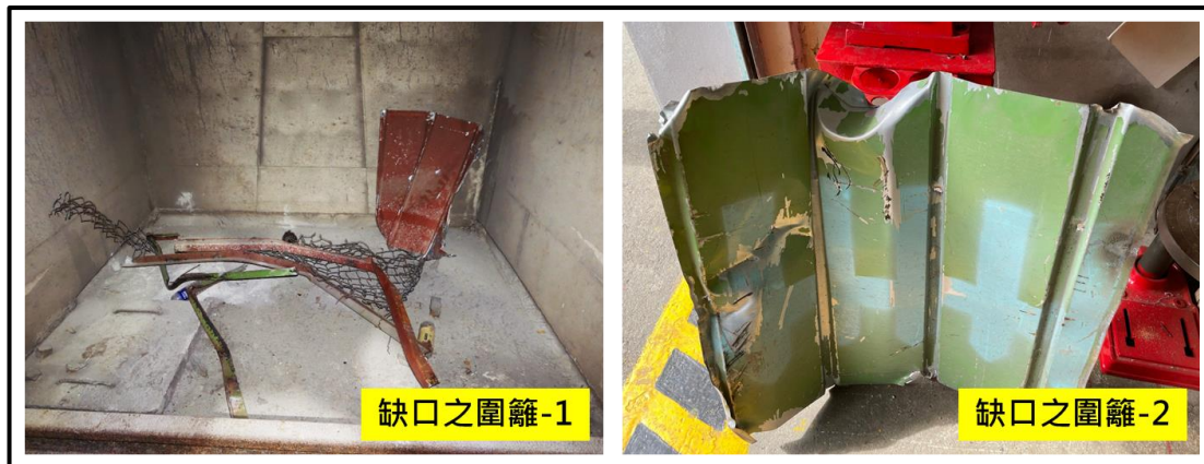
圖 1.3-11 缺口之施工圍籬
