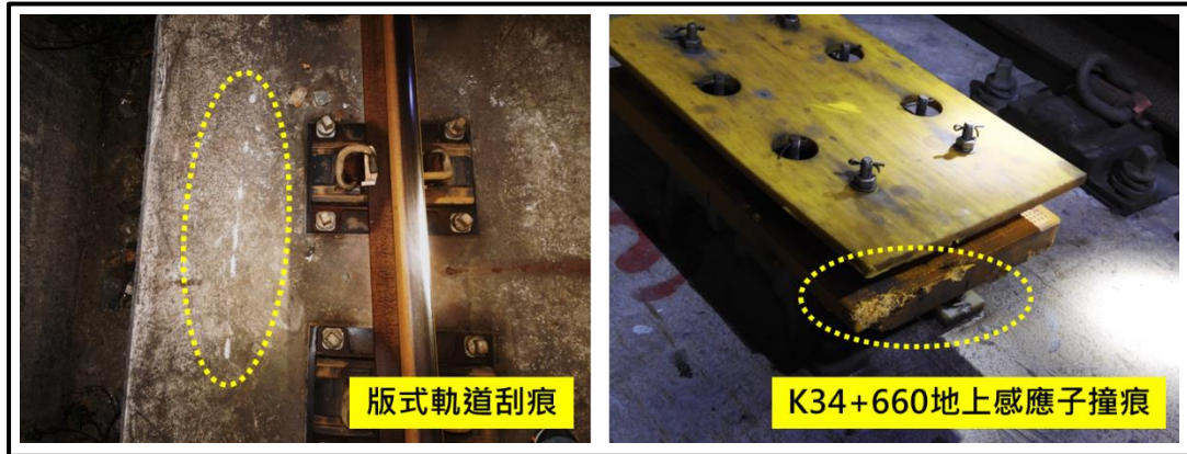
圖 1.3-9 設備損傷相關照片
