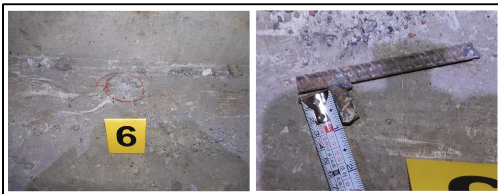
圖 1.11-3 現場底柱鋼筋檢視
