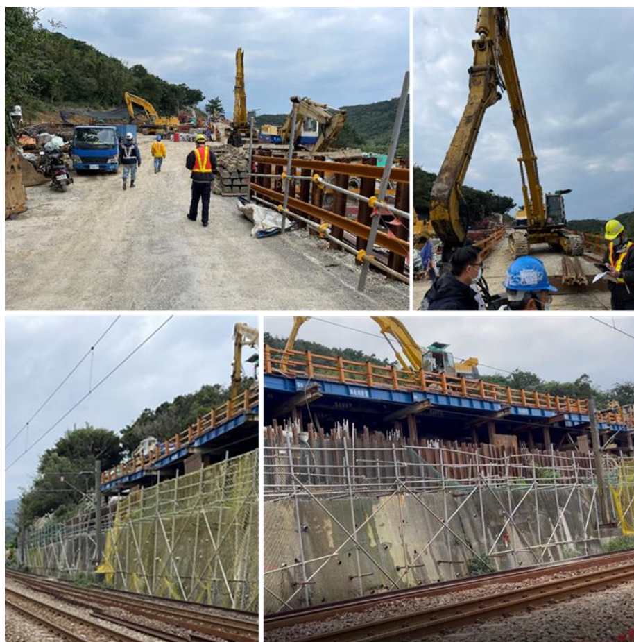
圖 1.1-2 事故當日施工現場
