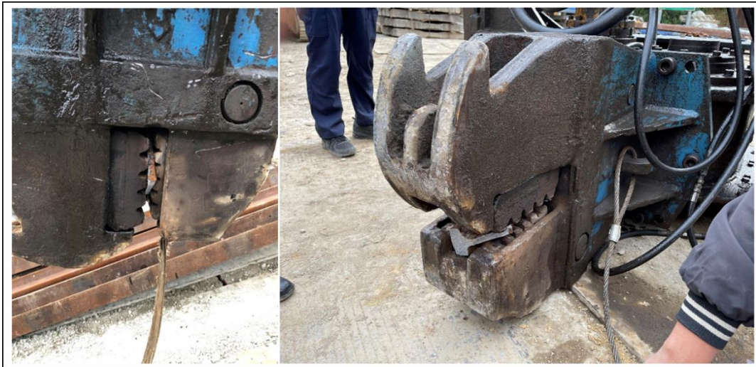
圖 1.6-9 夾頭內斷裂鋼軌樁
