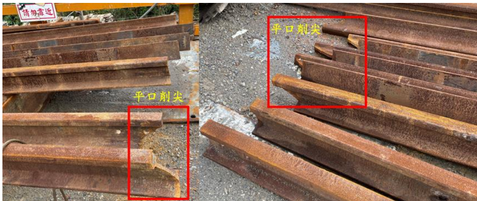
圖 1.10-1 施工現場鋼軌樁平口削尖圖
