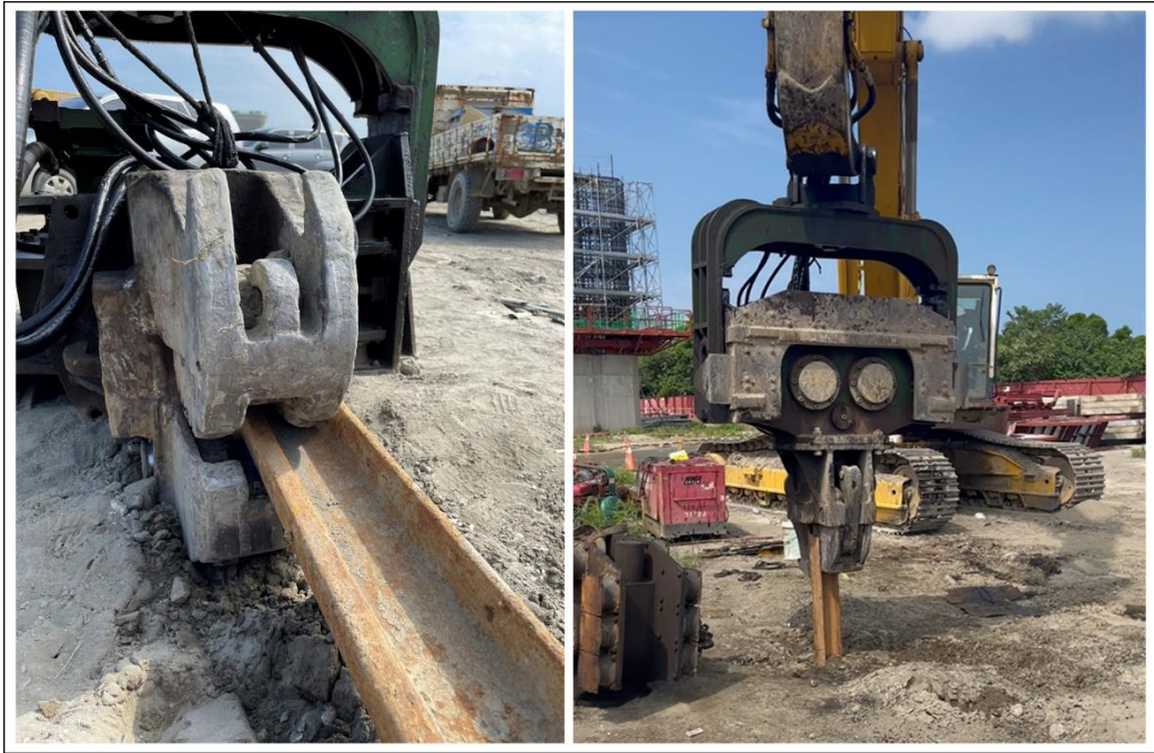
圖 1.6-8 鋼軌樁夾持及打入方式（非事故現場）
