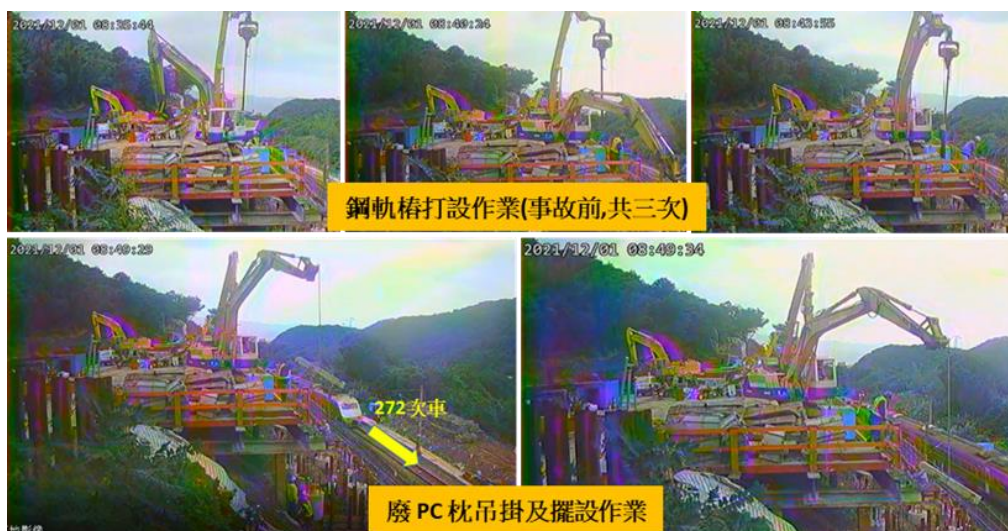
圖 1.1-6 事故前鋼軌樁打設及廢 PC 枕吊掛擺放作業
