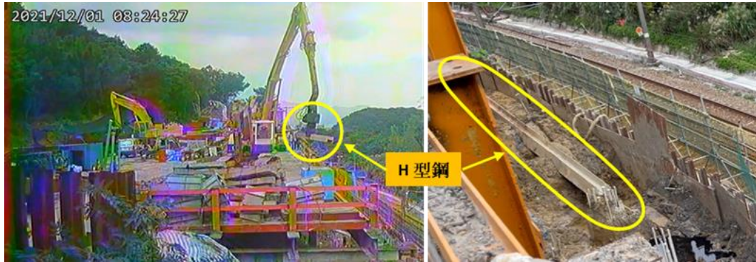
圖 1.1-3 H 型鋼擺設作業
