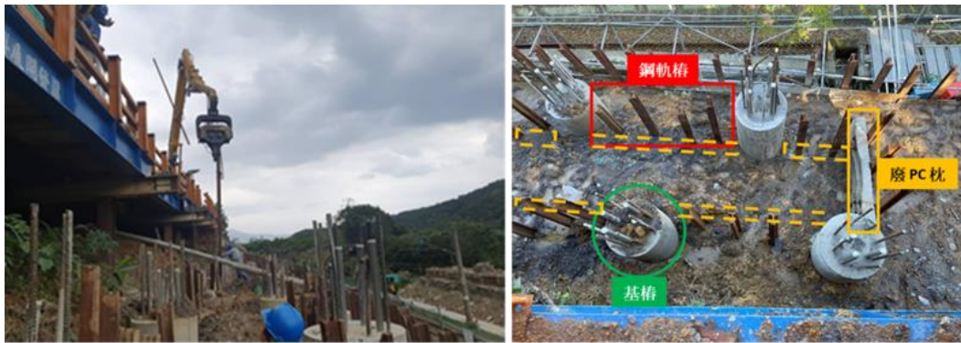
圖 1.1-3 H 型鋼擺設作業
