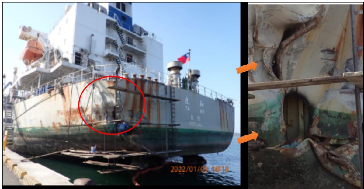
圖 2 達和輪左船艙受損現場照片
