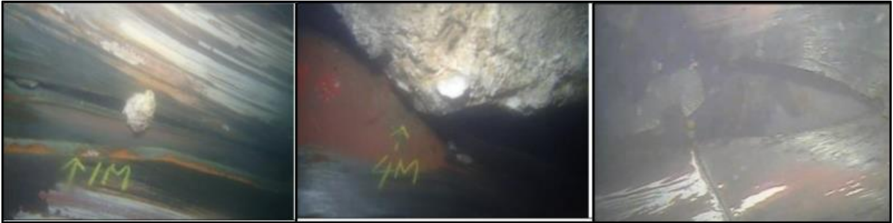
圖 10 右舷 83 至 88 號肋骨舳列板裂口
