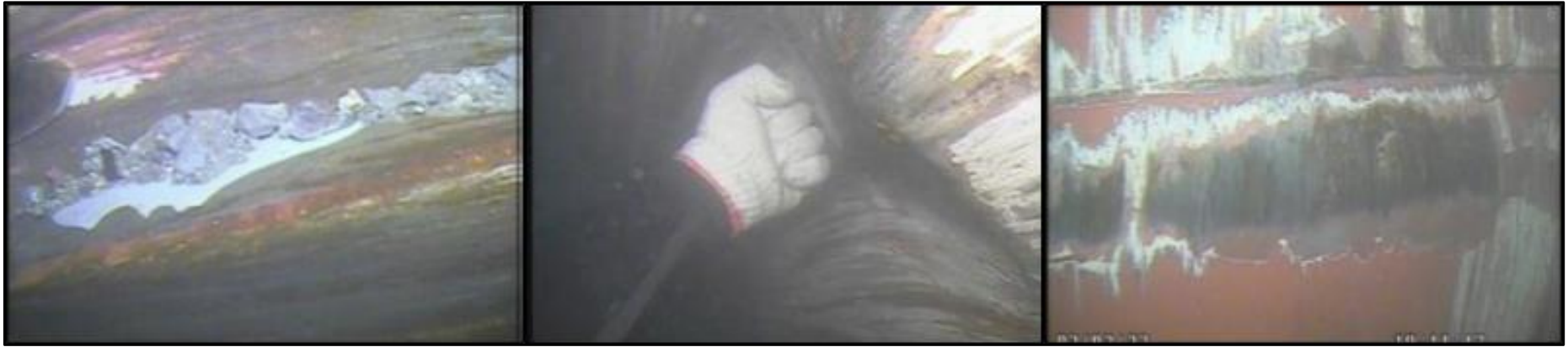
圖 13 左舷 78 至 84 號肋骨舳列板裂縫、凹陷及刮痕
