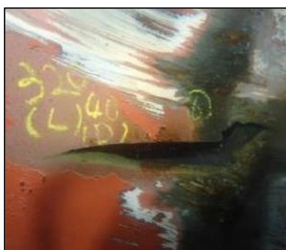
圖 8 右舷 47 號肋骨船殼處裂口
