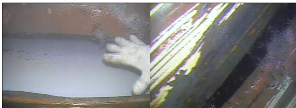
圖 9 右舷 56 至 58 號肋骨船殼裂口
