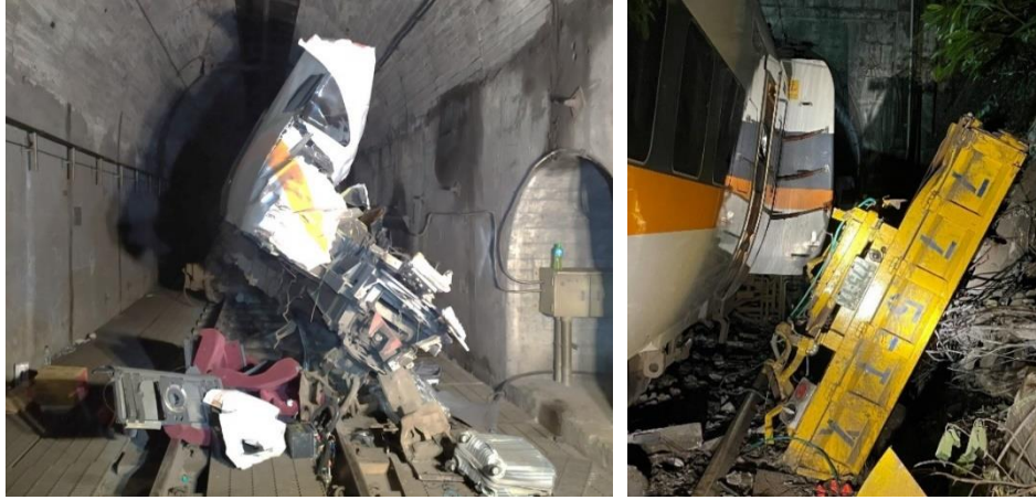
圖 2.1.3-10、圖 2.1.3-11 0402 臺鐵第 408 次車清水隧道重大鐵道事故照片
