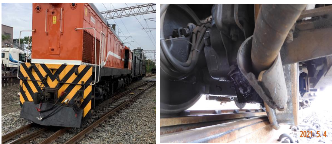
圖 2.1.3-16、圖 2.1.3-17 0504 臺鐵第 7142 次車成功站重大鐵道事故照片
