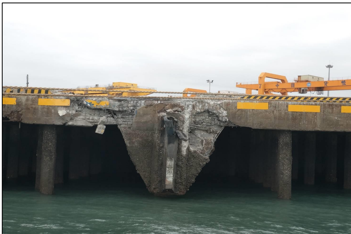
圖 3 臺中港 8A 號碼頭損害現場照片
