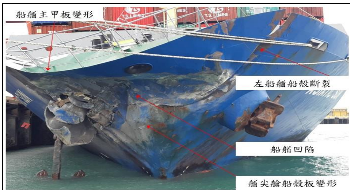
圖 2-1 德翔日光船體損害現場照片
