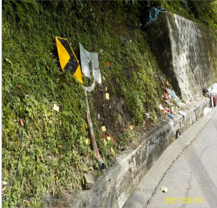
圖 1.4-1 事故現場邊坡及標誌損壞情形
