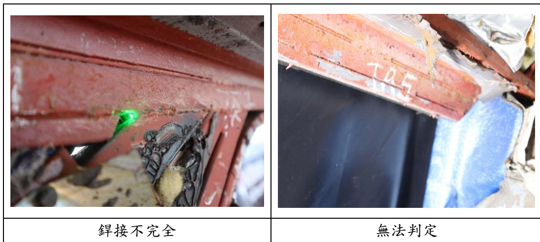
圖 1.3-32 事故車輛右側環肋銲接情形
