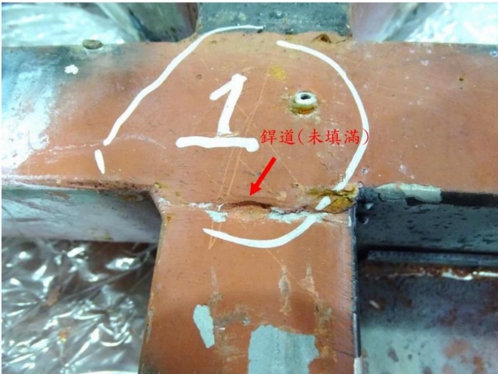
照片八：左側骨架未斷裂處 (No.L1) 銲接處銲道局部未填滿(underfill)瑕疵
