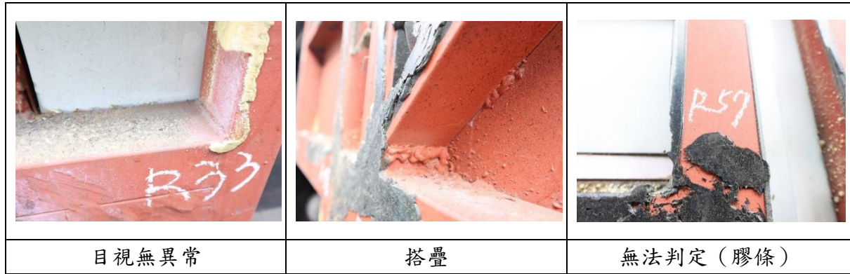
圖 1.3-31 事故車輛右側銲接情形
