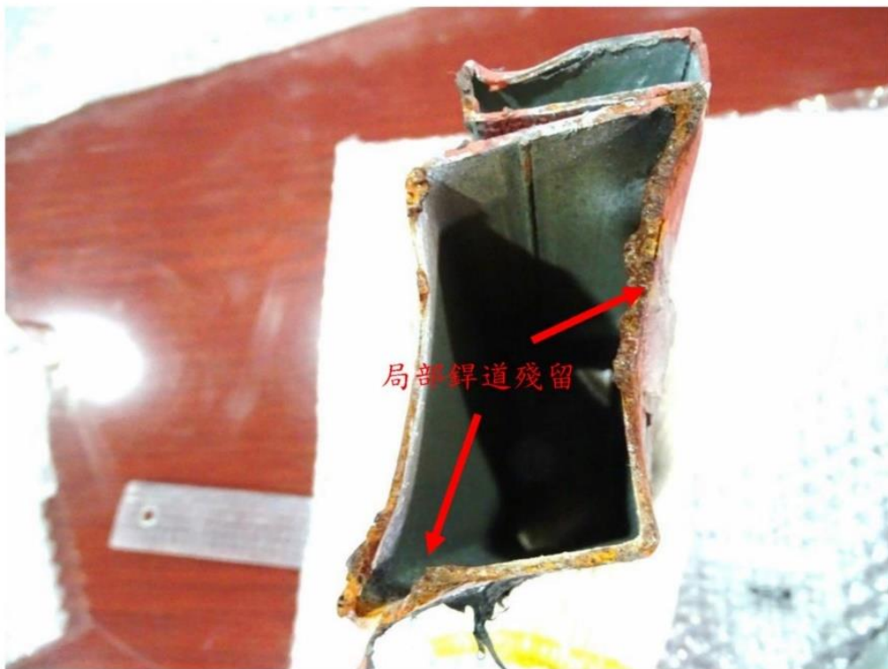
照片十四：左側骨架斷裂處 (No.L3-2) 有彎曲變形，斷裂面呈現快速破壞形貌，局部鐳道殘留
