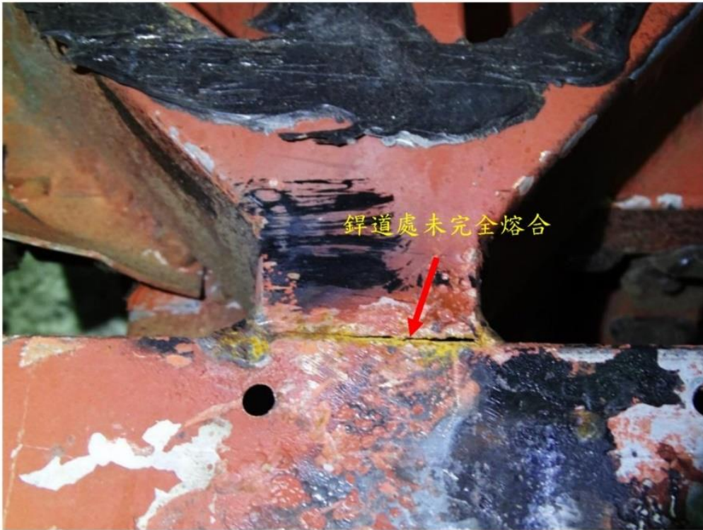
照片二十一：右側骨架未斷裂處 (No.R6) 鐸接處鐸道未完全熔合，形成縫隙
