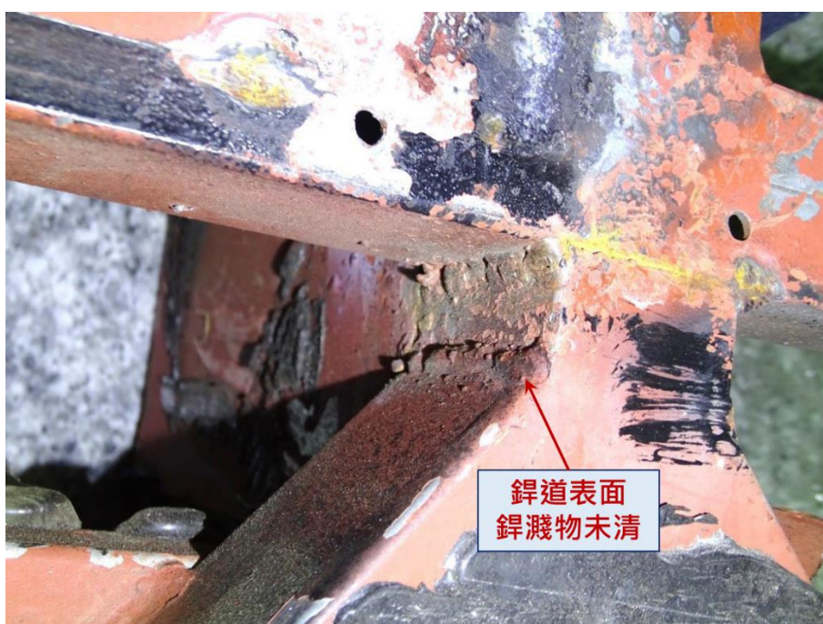
圖 1.13-11 右側骨架取樣 R6 銲道表面銲濺物未清除
