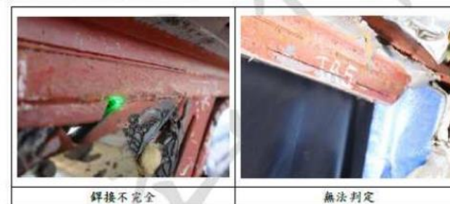
圖 1.3-32 事故車輛右側環肋銲接情形
