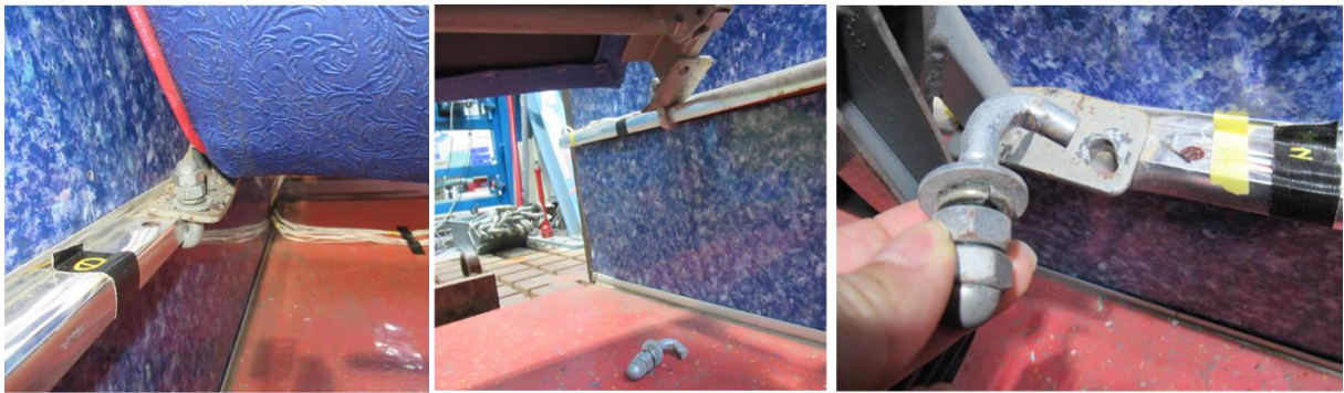
圖 1.13-22(a) 測試後靠窗側座椅固定裝置
