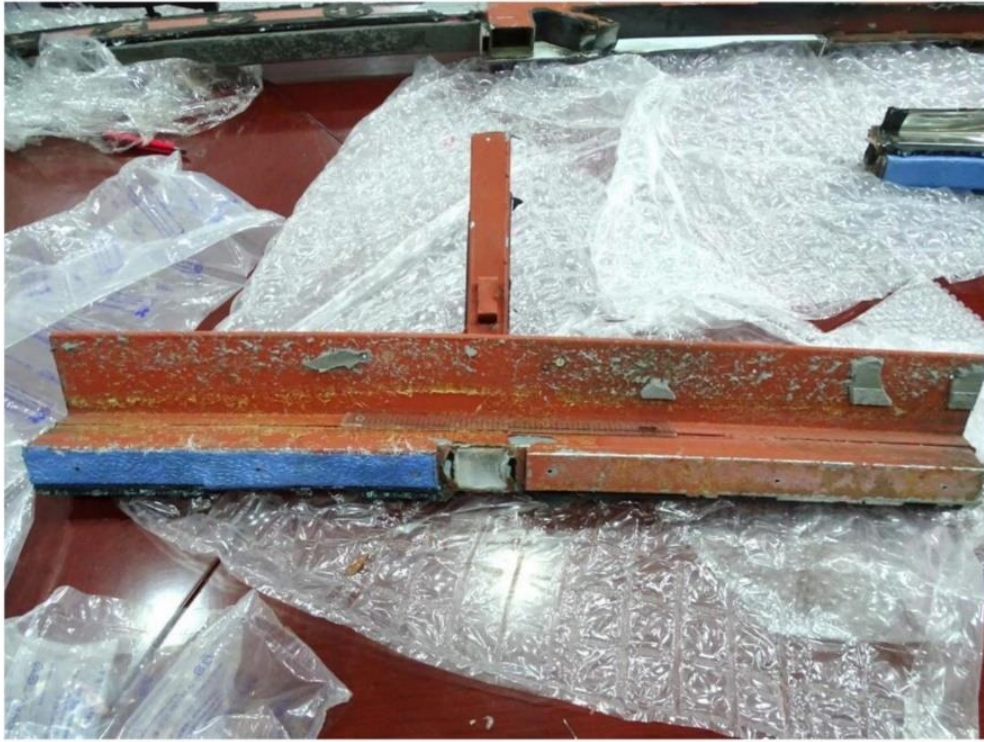
照片十九：左側骨架斷裂處 (No.L3-5) 斷裂面呈現快速破壞形貌，局部銲道殘留
