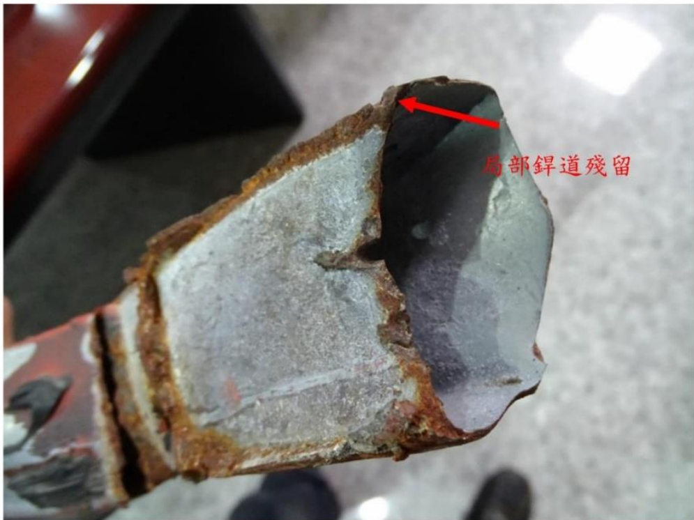
照片十六：左側骨架斷裂處 (No.L3-3) 有彎曲變形，斷裂面呈現快速破壞形貌，局部銲道殘留
