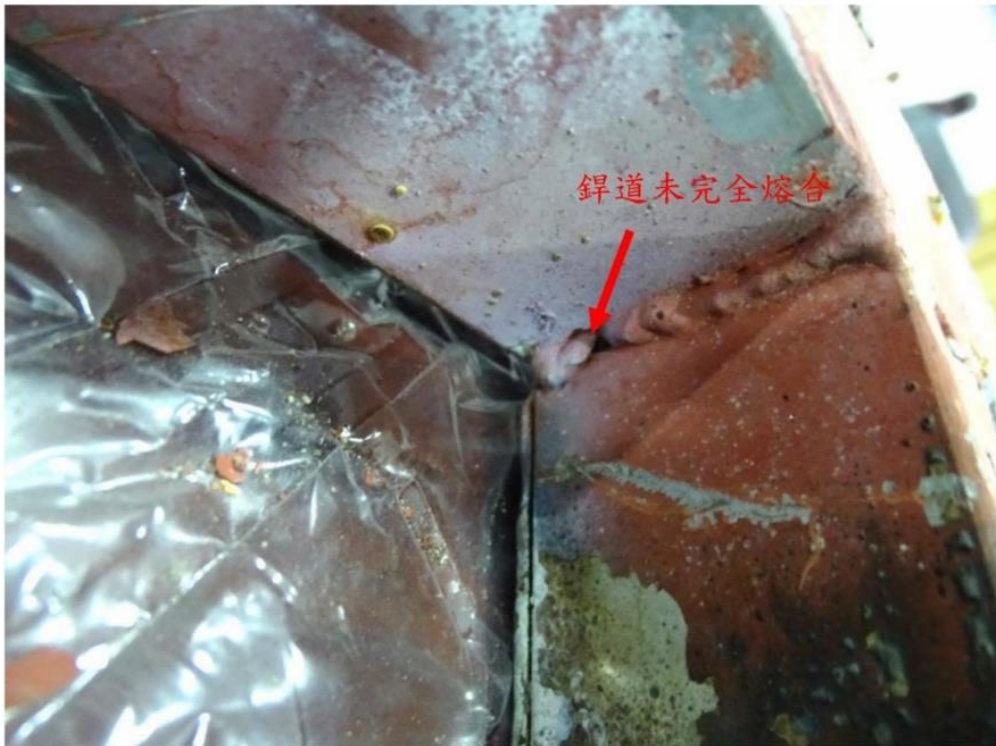
照片十：左側骨架未斷裂處 (No.L1) 銲接處局部銲道未完全熔合
