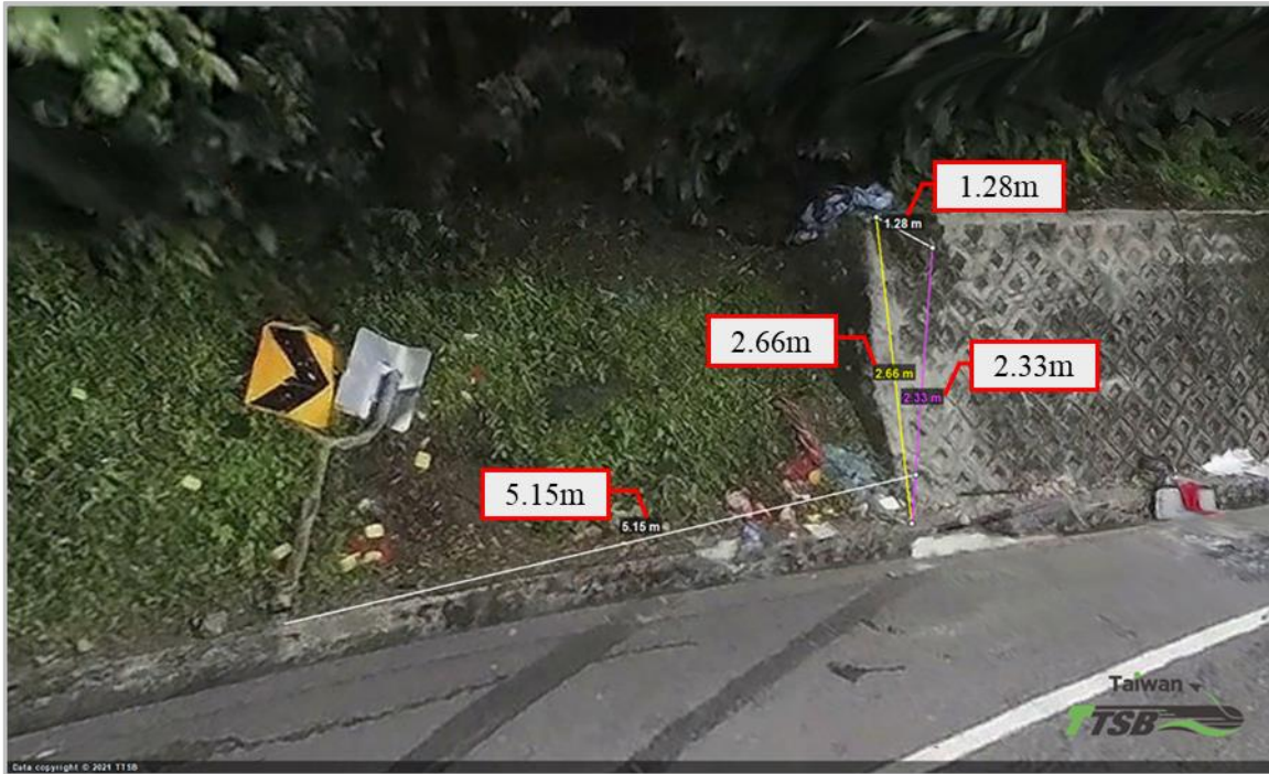
圖 1.10-3 事故車輛撞擊擋土牆斜面長度及高度測量
