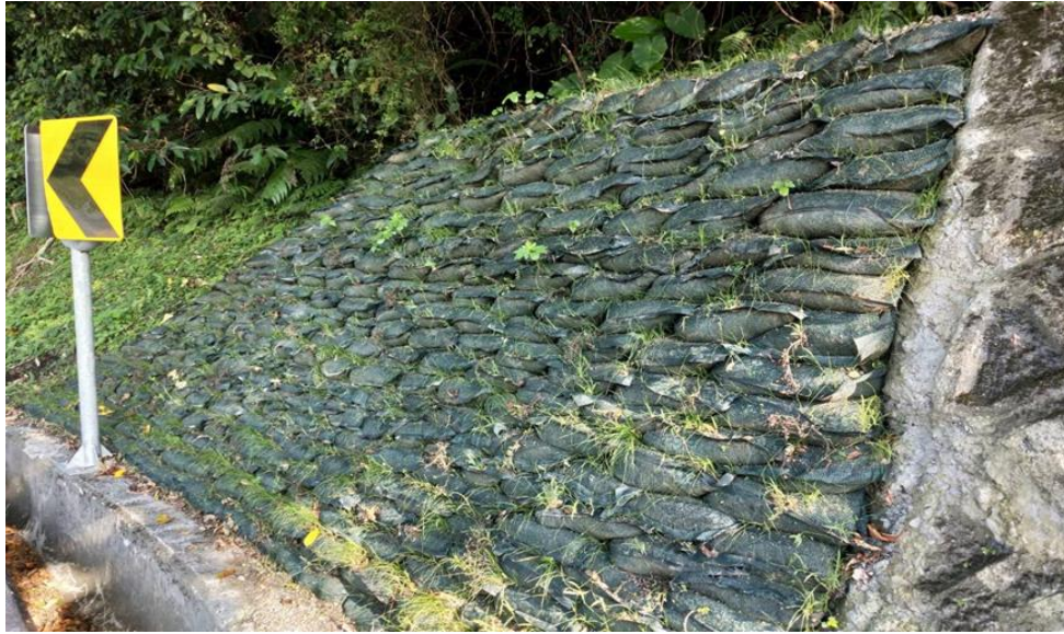
圖 4.2-1 事故後填補擋土牆邊角
