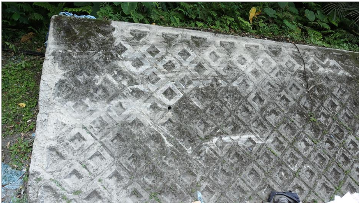
圖 1.10-4 事故車輛撞擊擋土牆所遺留之刮痕
