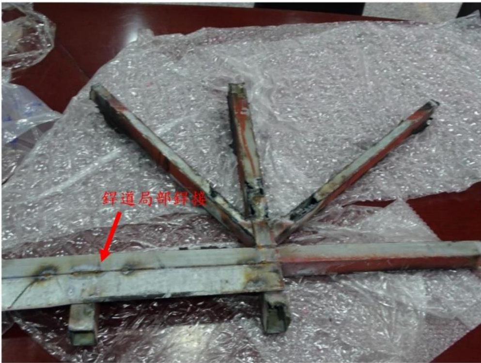
照片十一：左側骨架未斷裂處 (No.L1) 背面之銲接處鋁道只有局部銲接(暫銲)
