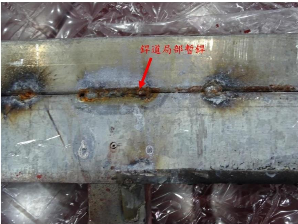
照片十二：左側骨架未斷裂處 (No.L1) 背面之銲接處鋁道只有局部暫銲
