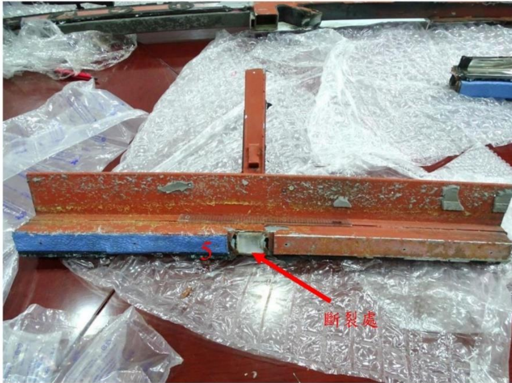
照片五：左側骨架斷裂處 (No.L3) 取樣後外觀 (取 4 處 No.L3-2、No.L3-3、No.L3-4 與 No.L3-5)
