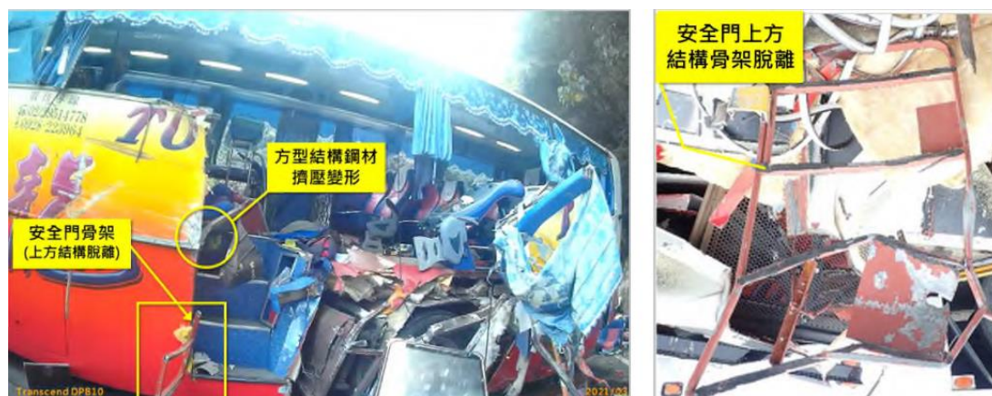
圖 2.3-21 事故車輛安全門至車尾結構破壞情形
