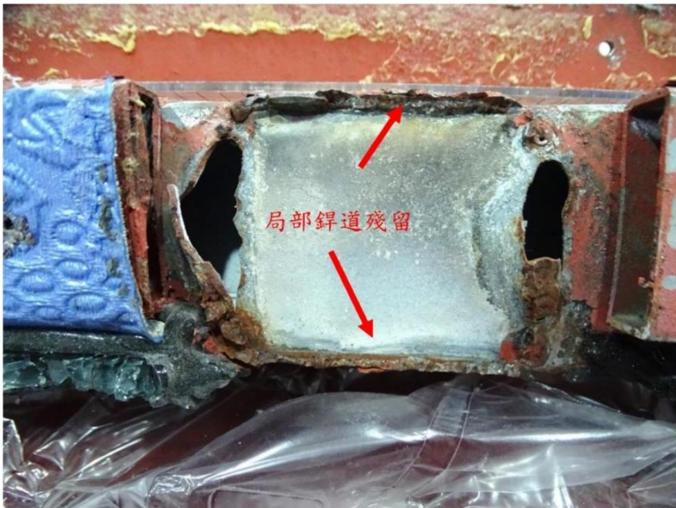
照片二十：左側骨架斷裂處 (No.L3-5) 左右銲道有受力彎曲變形扯斷，斷裂面呈現快速破壞形貌，上下銲道平整斷裂無受力變形之形貌、局部銲道殘留，此柱為環肋的一部分。
