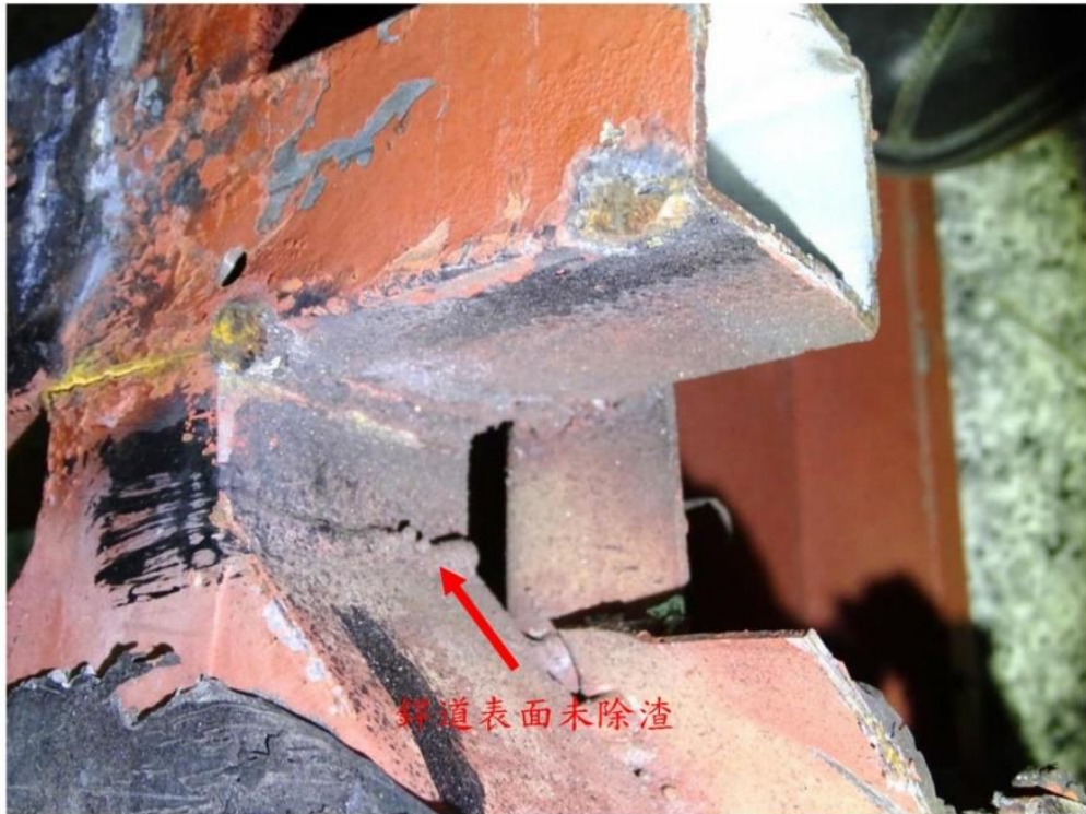
照片二十三：右側骨架未斷裂處 (No.R6) 銲接處銲道表面未除渣
