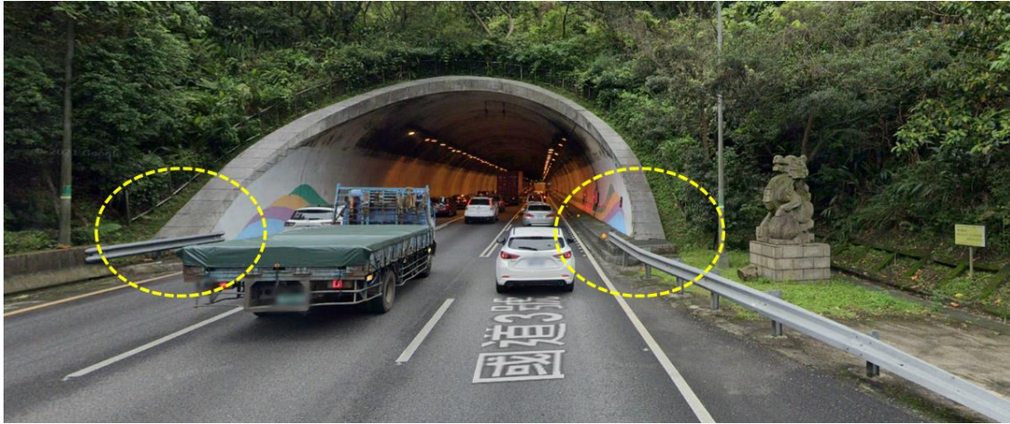
圖 2.4-1 高速公路隧道口護欄設置案例
