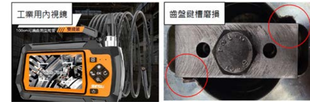
使用工業內視鏡檢視齒盤鍵槽及固定鍵是否磨損
