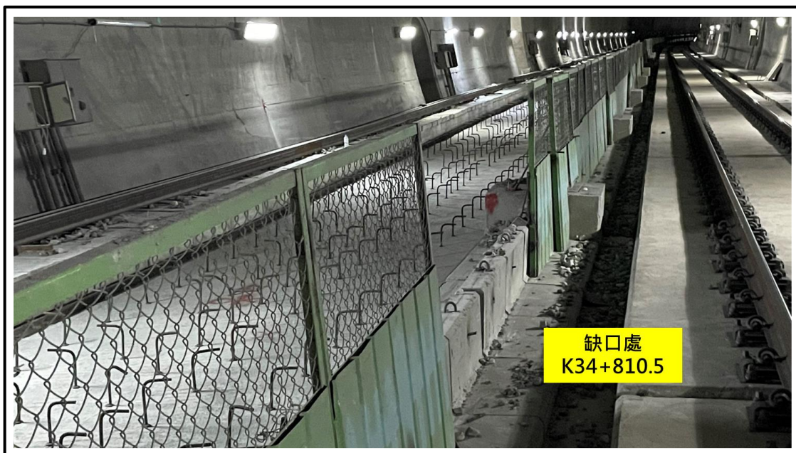
圖 1.3-10 鳳林隧道施工圍籬缺口處（攝於民國 110 年 12 月 2 日）
