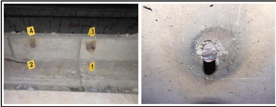
圖 1.11-2 現場連壁鋼筋檢視
