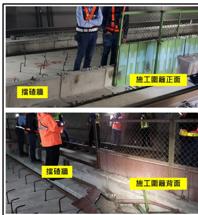
圖 1.8-5 鳳林隧道施工圍籬照片（攝於民國 110 年 12 月 2 日）
