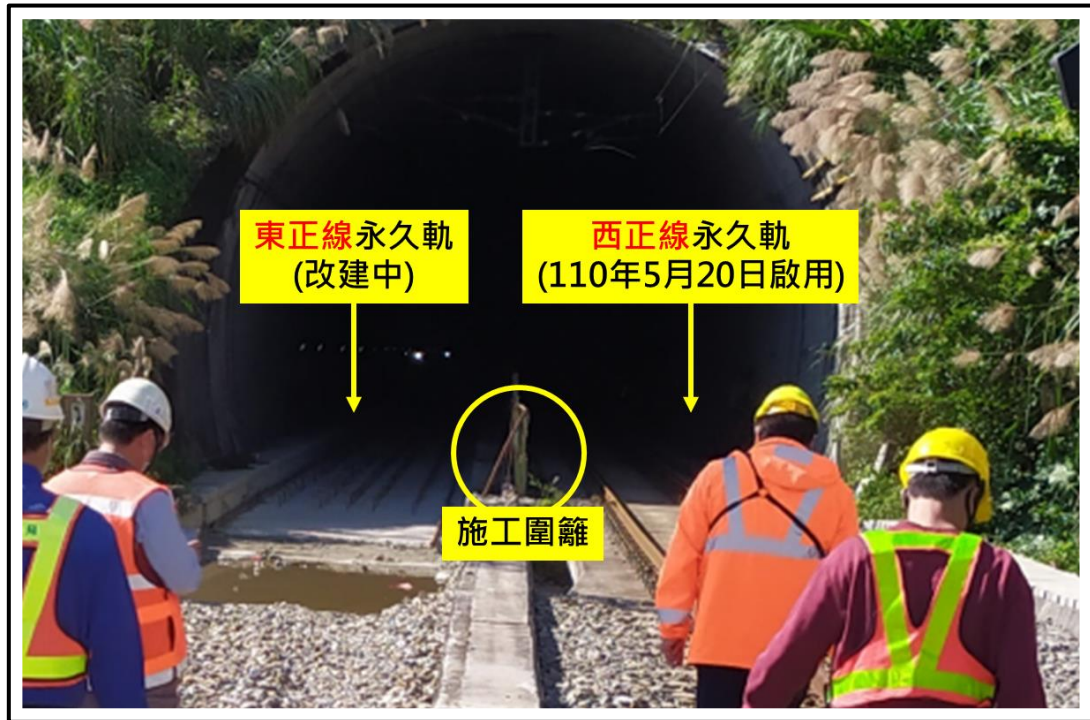
圖 1.1-3 鳳林隧道路線示意（攝於民國 110 年 12 月 2 日北洞口）
