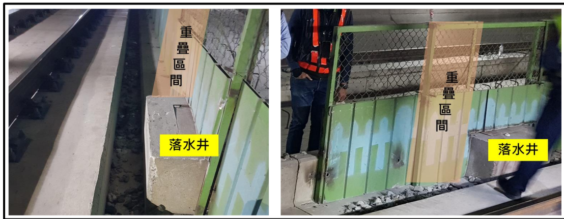
圖 2.2-2 施工圍籬重疊搭設
