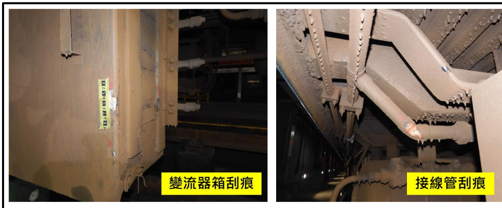
圖 1.3-8 事故列車第 4 車車廂損害照片
