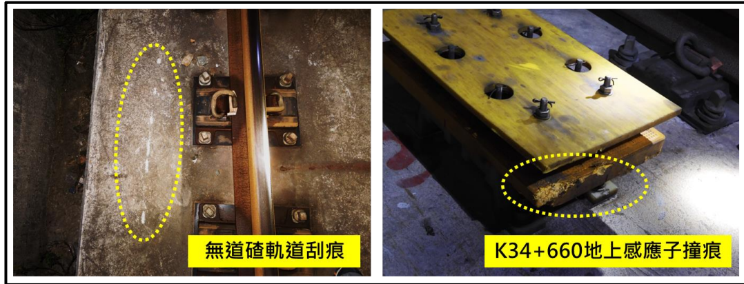
圖 1.3-9 設備損傷相關照片
