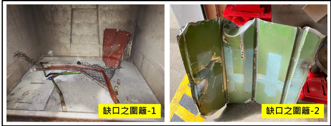
圖 1.3-11 缺口之施工圍籬
