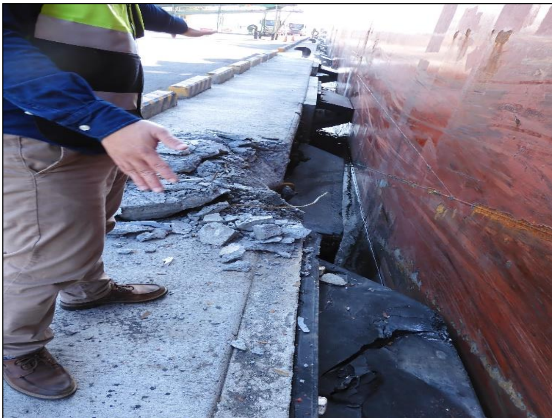
圖 3 安平港 6 號碼頭受損現場照片
