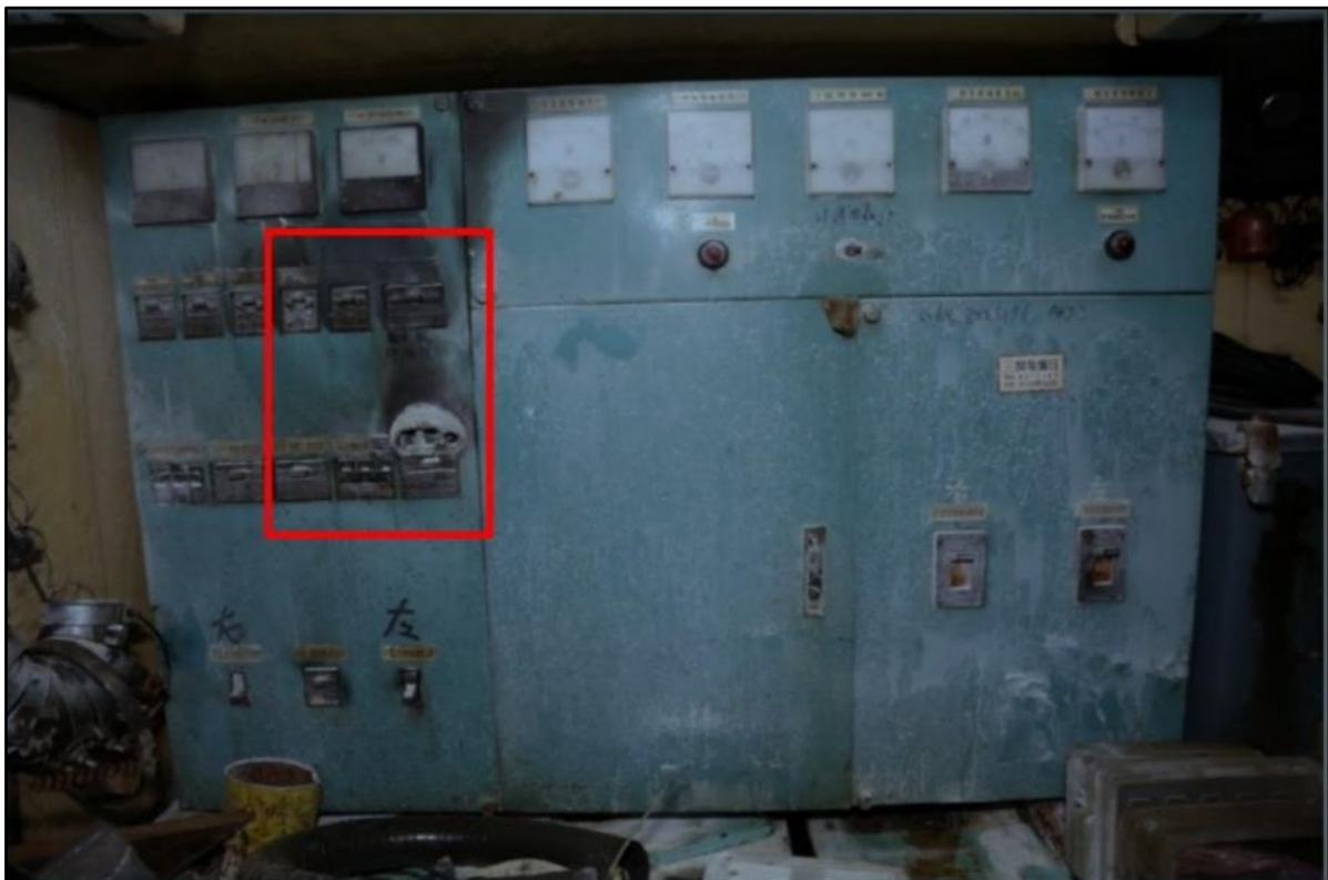
圖 8 永船上機艙左側配電盤及發電機盤之煙燻及滅火器乾粉痕跡圖
