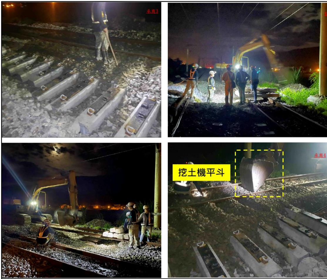
圖 1.6-2 現場施工照片
