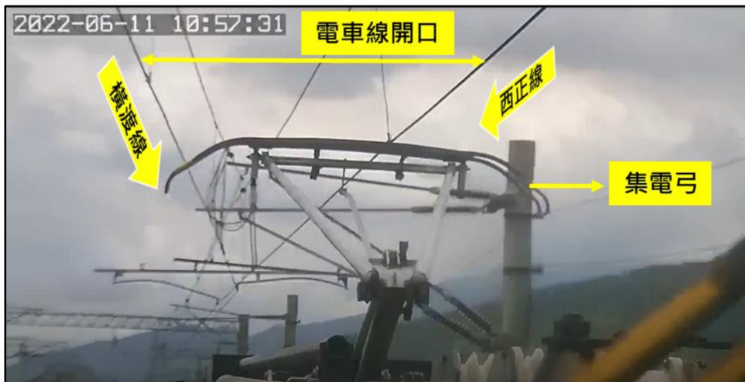
圖 1.7-24 第 6046 次車集電弓通過重疊區間
