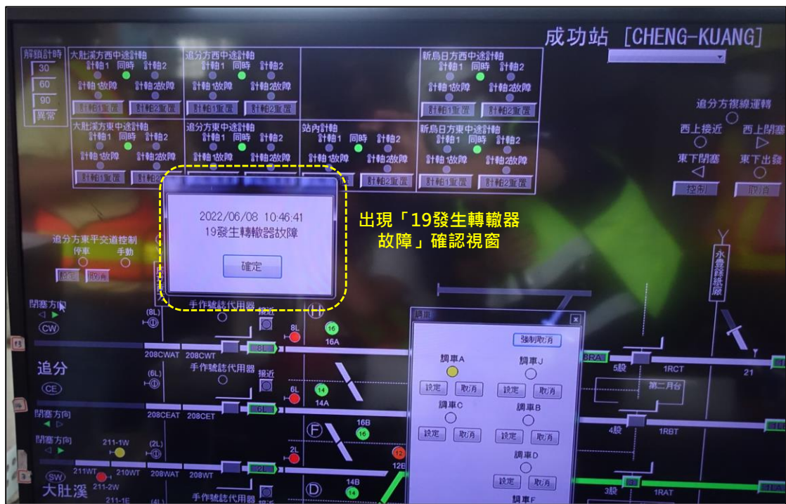
圖 1.15-4 轉轍器告警測試_3 (5 公厘厚鐵片)
