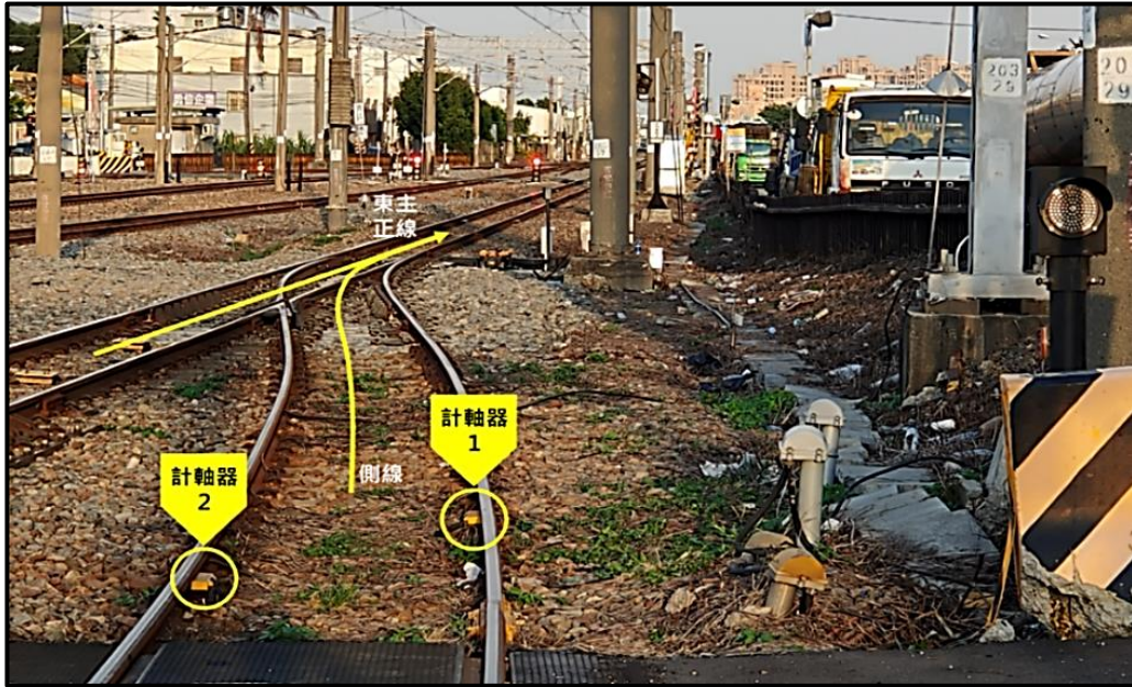
圖 1.9-6 雙計軸器現場配置示意
