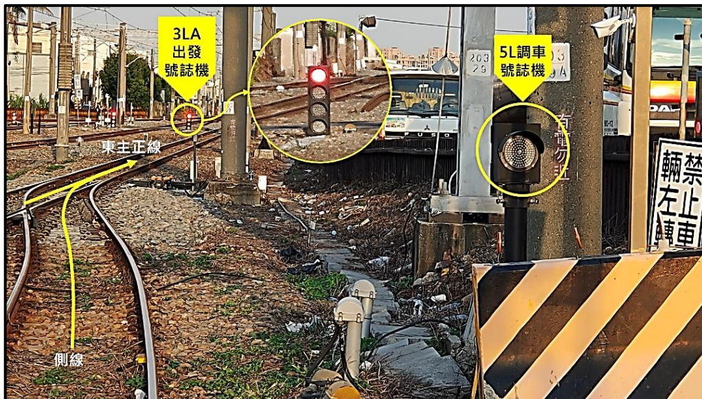
圖 1.9-4 成功站 5L 調車號誌機及 3LA 出發號誌機現場位置
