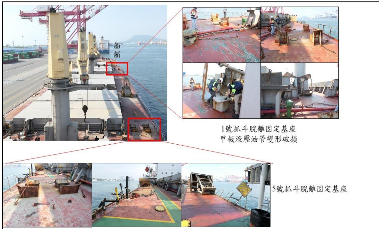
圖 1.3-1 主甲板右舷抓斗及油壓管受損照片
