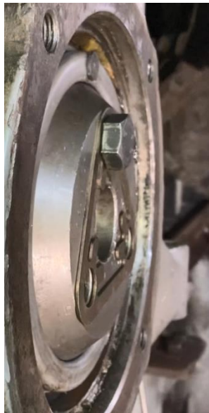
圖 1.7-6 螺絲孔清潔後螺絲試安裝情形
