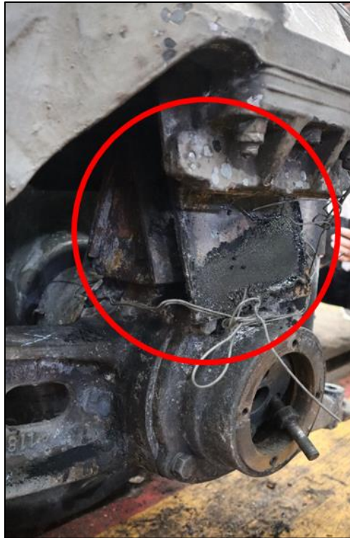
圖 1.3-4 人形橡膠簧損害情形
