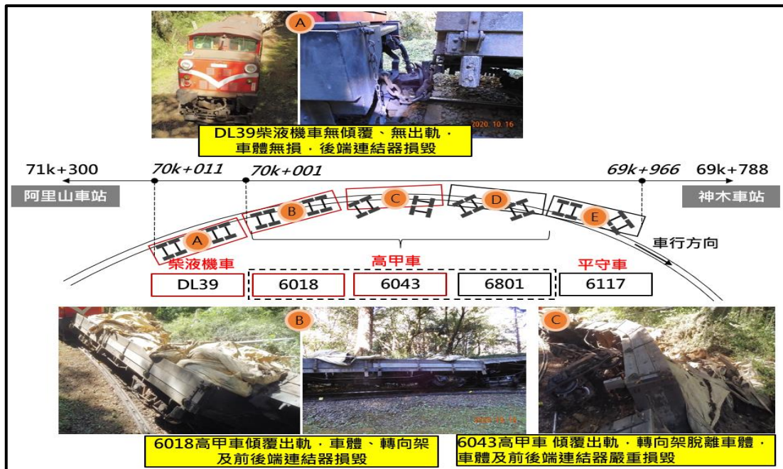
圖 1.4-1 貨物列車損害概況 (1)
