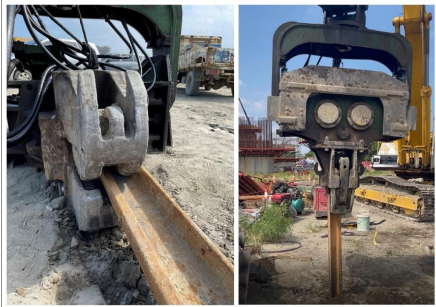
圖 1.10-2 打樁機夾頭夾持鋼軌樁示意圖（非事故現場）
