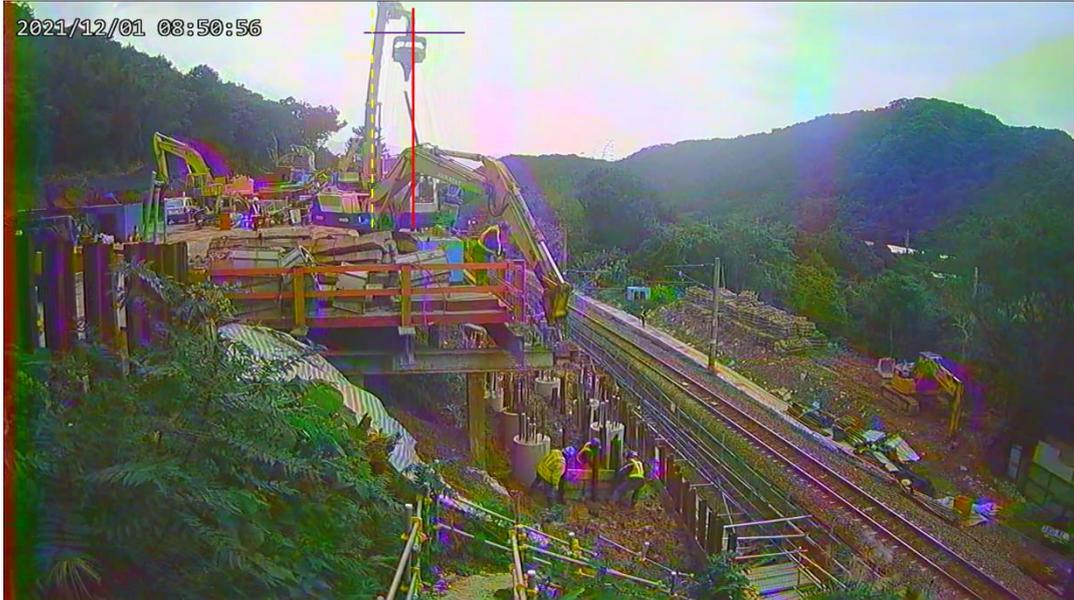
圖 2.1-6 鋼軌樁斷裂及掉落
