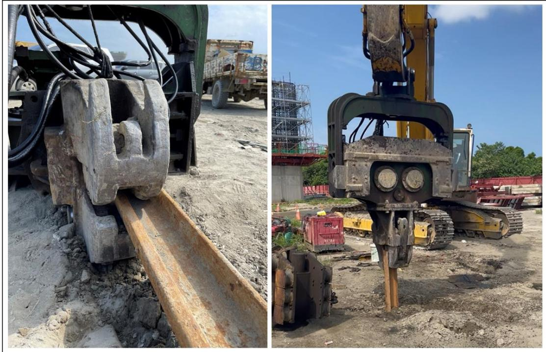
圖 1.5-8 鋼軌樁夾持及打入方式（非事故現場）
