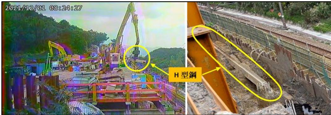
圖 1.1-3 H 型鋼擺設作業
