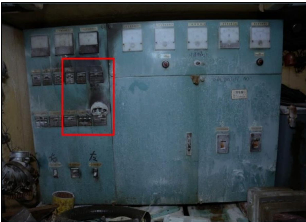
圖 8 永船上機艙左側配電盤及發電機盤之煙燻及滅火器乾粉痕跡圖
