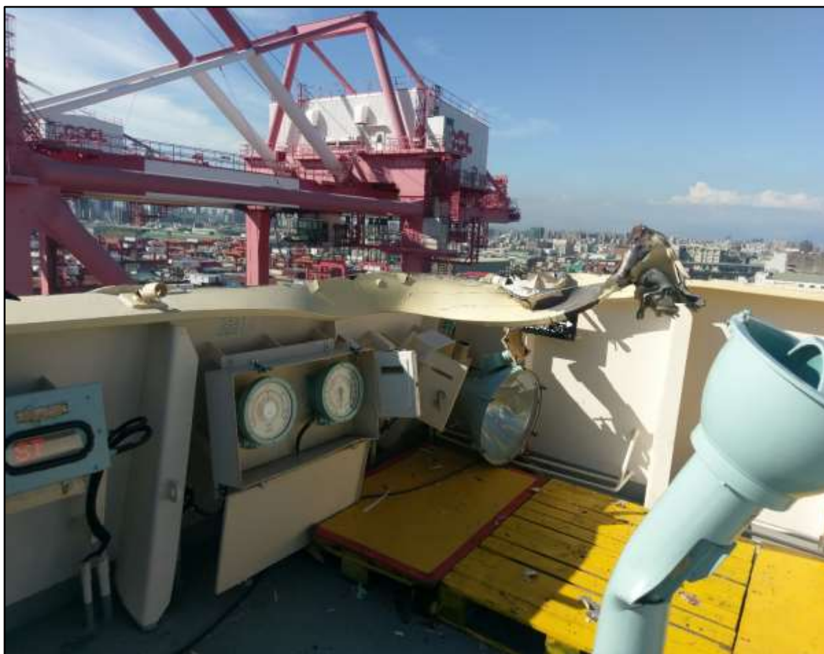
圖 3 東方德班駕駛臺右舷船橋損傷圖
