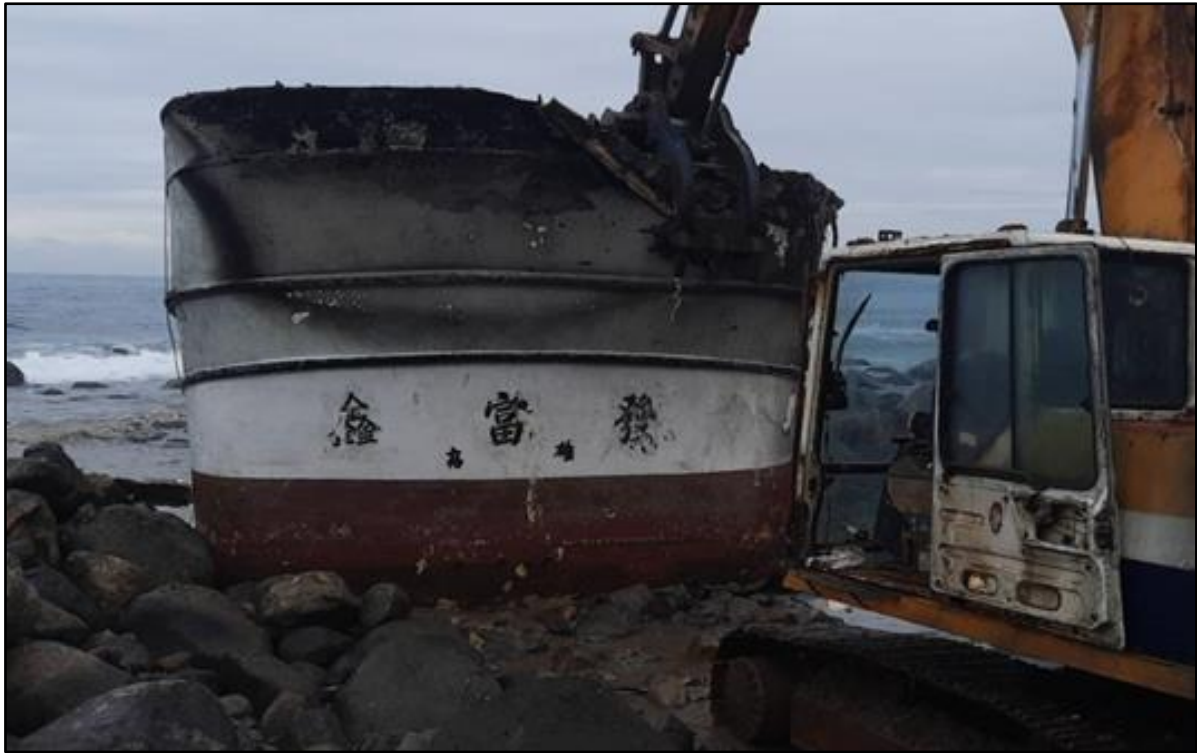
圖 2「鑫富發」漁船拆解情況
