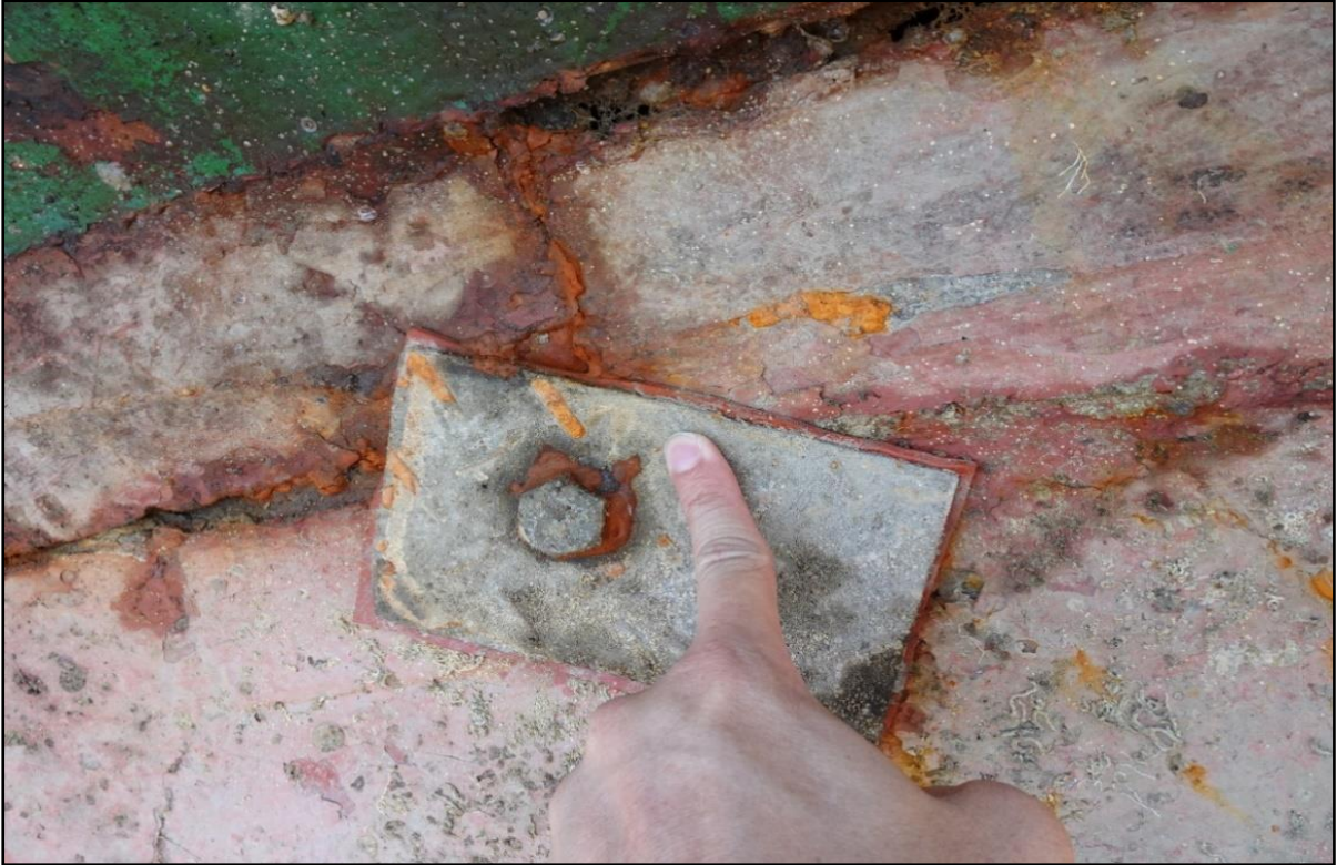
圖 24 東洋 6 號船艙使用夾板、墊片及螺桿修理處之二
