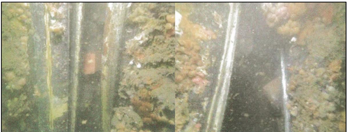
圖 6 鋼板樁裂縫
