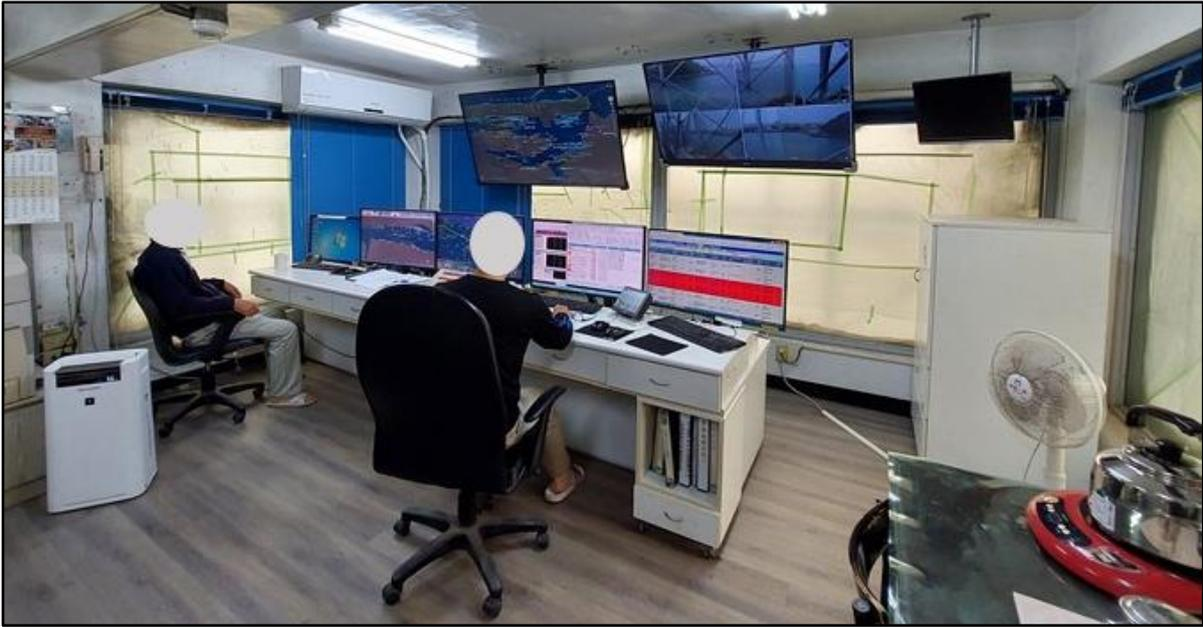
圖 6 一港口信號管制席監控系統畫面配置
