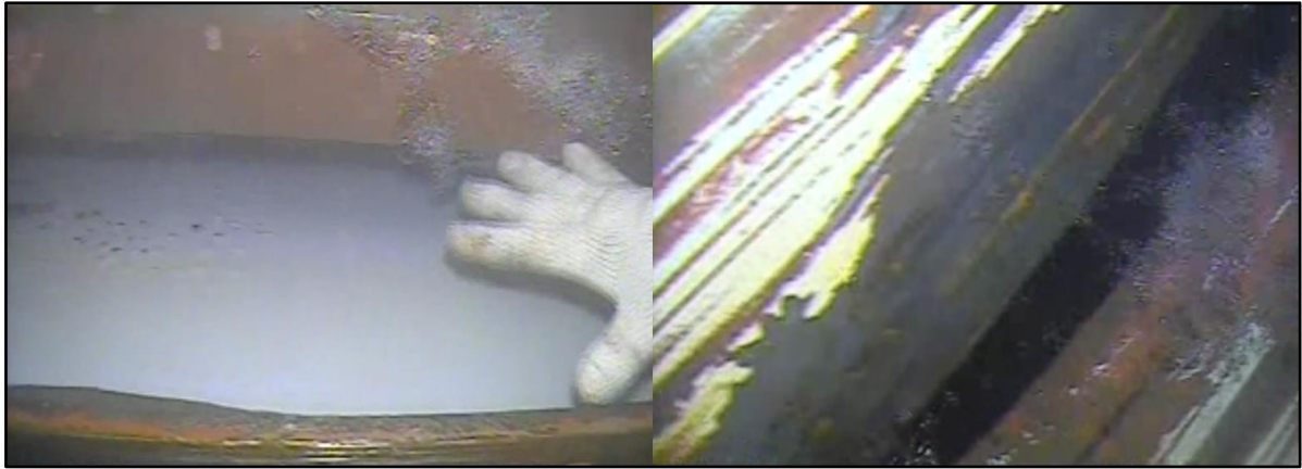
圖 7 右舷 56 至 58 號肋骨船殼裂口
