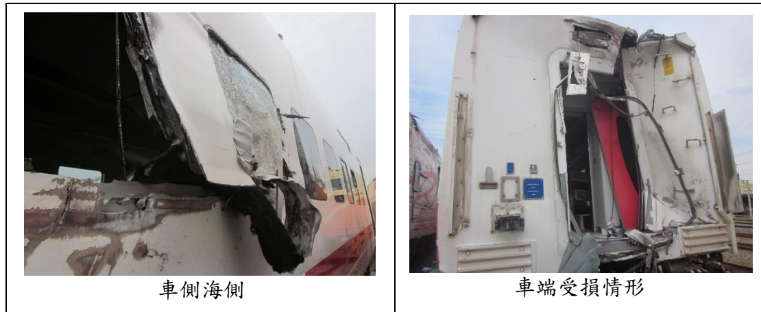
圖 1.3-8 第 6 車車廂損傷概況圖
