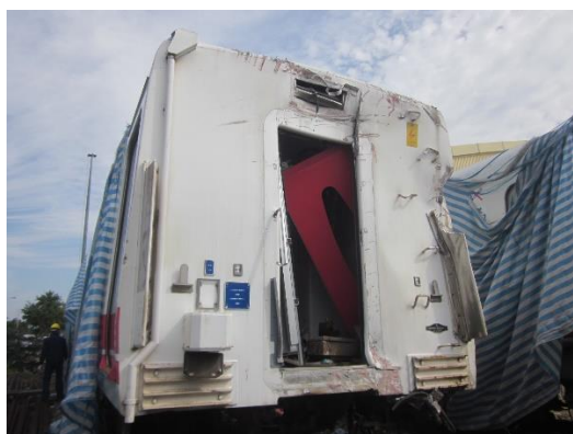
車端受損情形
