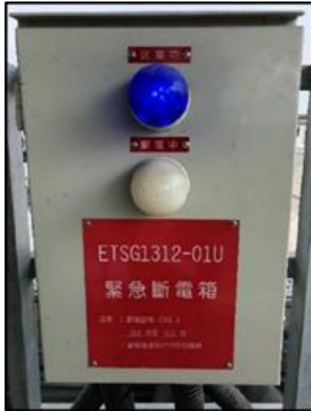
圖 7 緊急斷電箱
