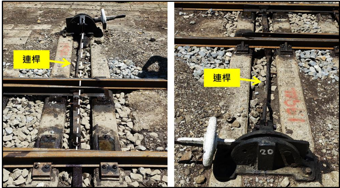
圖 12 第 20 號錘柄式轉轍器連桿變形情形（路基已整修）
